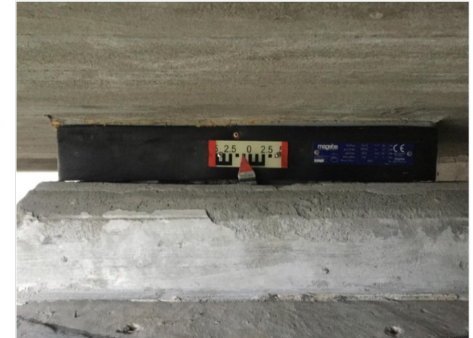
KOHDE KaS-14 Rantsilanmäen risteysilta • Laakeri (Kumipesälaakeri) 5 2 (I) KUVANOTTOAIKA 23.11.2018 TALLENNETTU 23.11.2018 klo 14:38 TAGIT lämpötila -1c° KUVALUOKKA D: Rakennesakava TALLENTAJA Simo Nykänen
