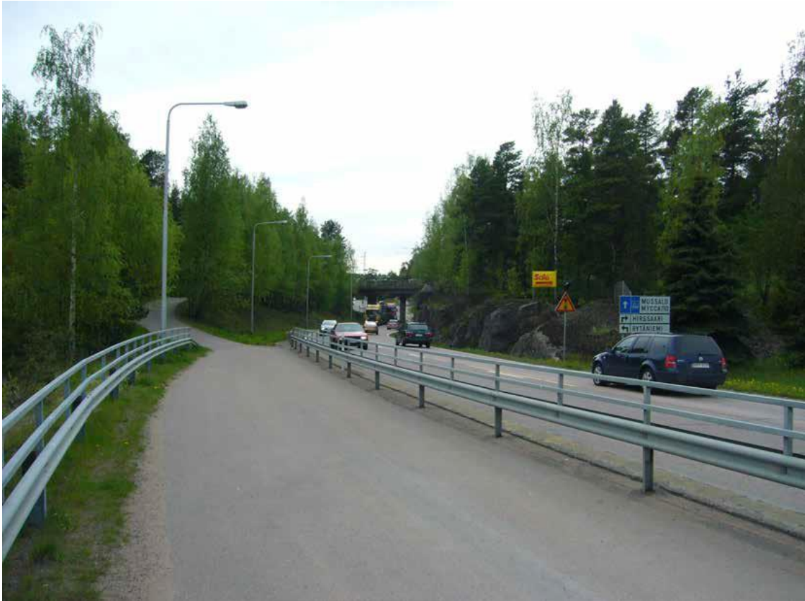
Kuva 2. Näkymä Merituulentieltä länteen kohti Hirssaarentien liittymää.
