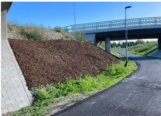
Kuva 3. Luiskia viimeistelty siltojen S101 ja S102 alueella.
