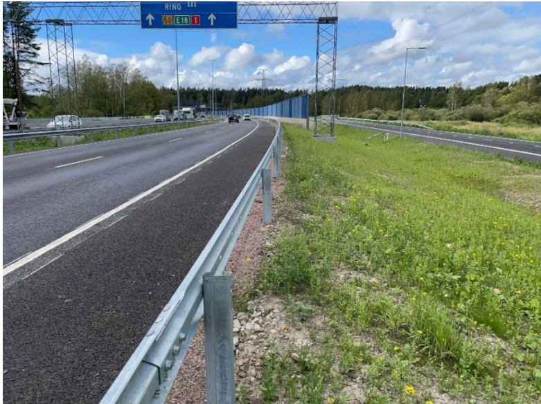
Kuva 4. Pengerkaiteet asennettu.
