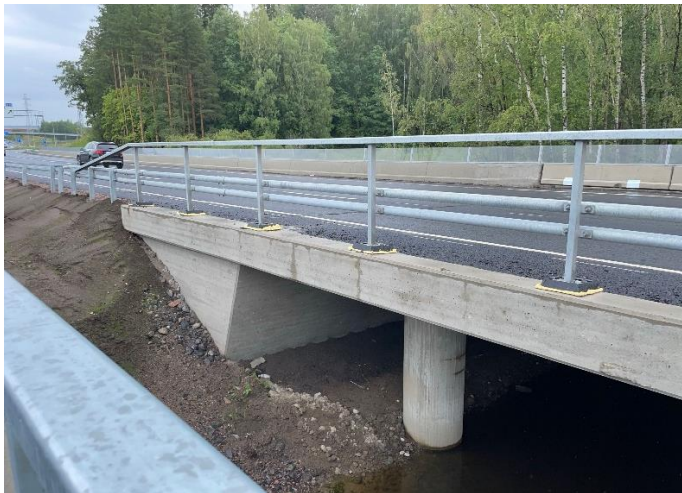
Kuva 2. Siltojen U-950 ja S104 kaiteiden juurivalut tehty.
