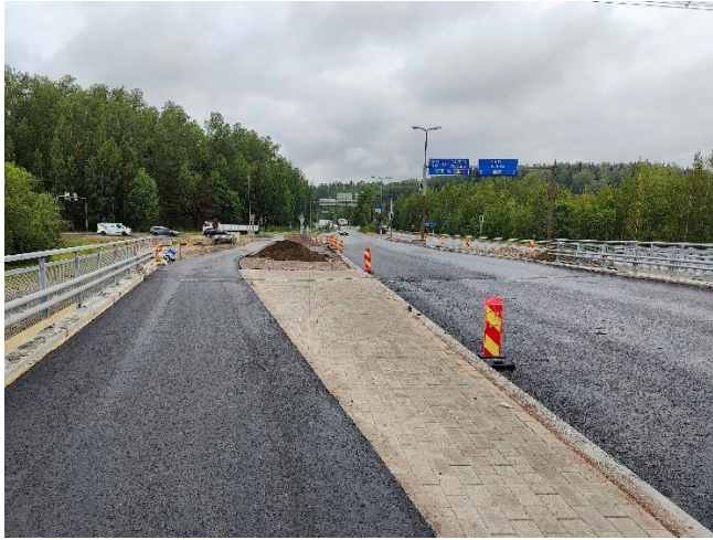
Kuva 1. Kivityöt valmistuneet sillalla S111. Silta on avattu kokonaisuudessaan liikenteelle.
