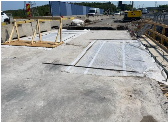
Kuva 2. Sillan U-950 kloridipitoiset alueet korjattu. Betonoitujen kohtien jälkihoito käynnissä.
