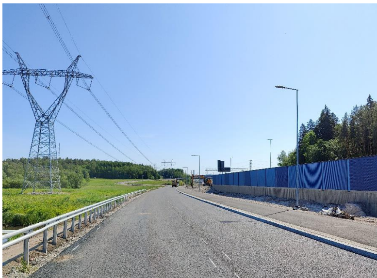
Kuva 5. Väylä K2 valmistumassa. Luiskien viimeistely käynnissä ja ajoratamerkinnät vielä tekemättä.
