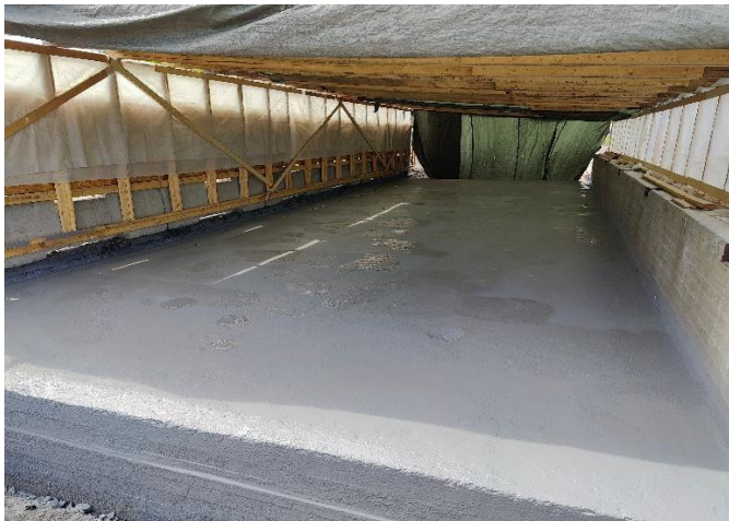
Kuva 2. Nestemäinen vedeneriste levitetty sillan U-950 pohjoiselle osalle.
