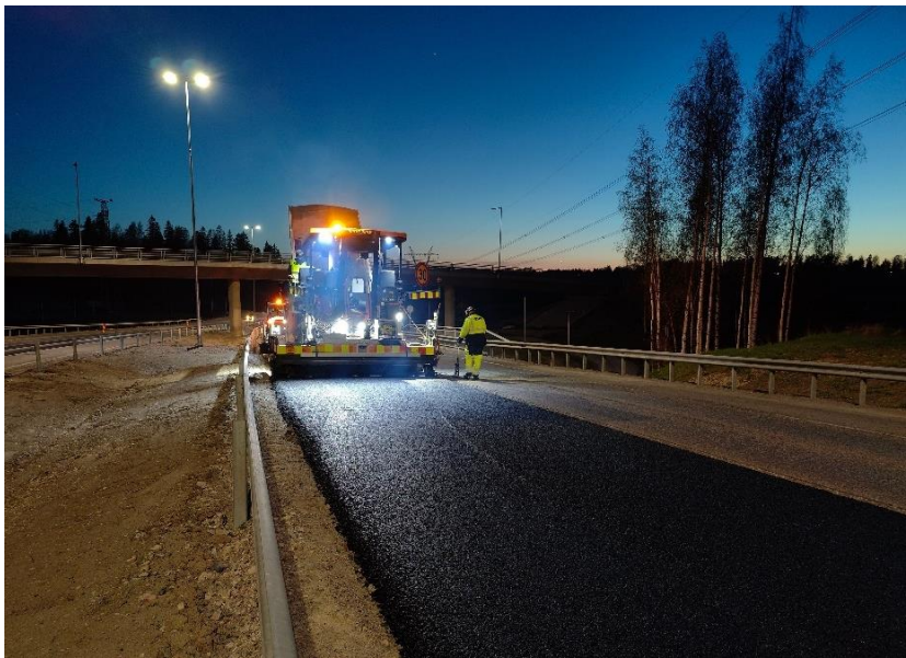
Kuva 4. Päällystystöitä on tehty öiseen aikaan.
