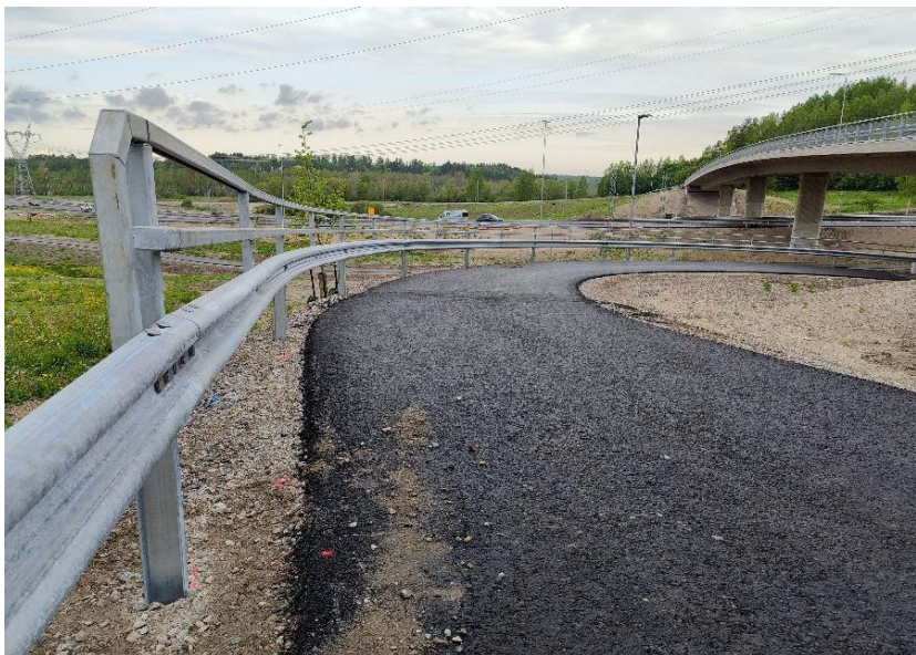
Kuva 5. Päällystystyöt tehty ja kaitteet asennettu sillan S106 alta kulkevalle kevyen liikenteen väylälle.
