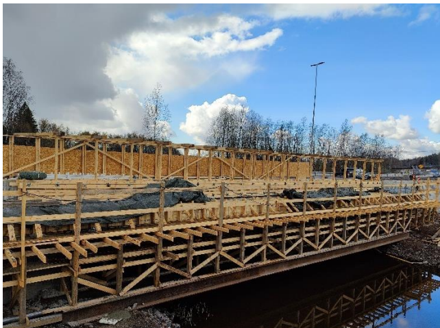
Kuva 2. Sillan U-950 reunapalkki valettu ja kannen sääsuojan rakentaminen käynnissä.
