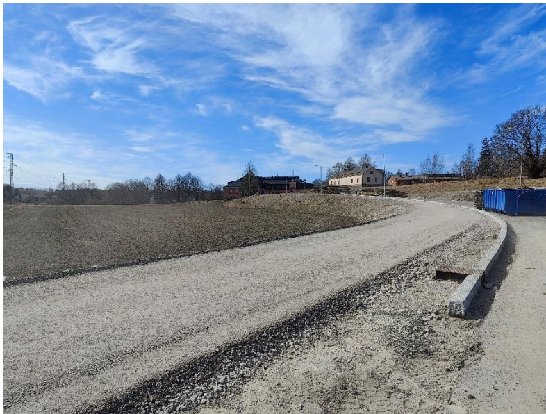
Kuva 4. Väylän K3J kantava kerros viimeistely. Reunakivityöt vaiheessa.
