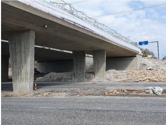
Kuva 1. Sillan S112 muotti on purettu. Sääsuojan rakentaminen siltakannen päälle käynnissä.
