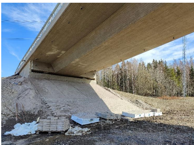
Kuva 3. Sillan S106 pohjoispuolen keilan kivityöt käynnissä.
