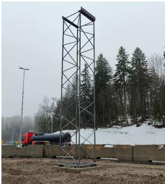
Kuva 4. Portaalien pystytys aloitettu Askistossa.
