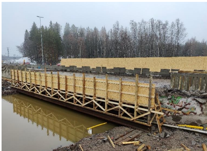
Kuva 2. Sillan U-950 kannen pintarakenteet purettu ja reunapalkin telineen rakentaminen käynnissä.
