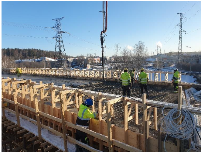
Kuva 1. S112 siltakannen betonivalu käynnissä.
