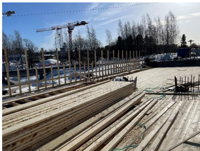
Kuva 3. Kannen laudoitus käynnissä sillalla S112.
