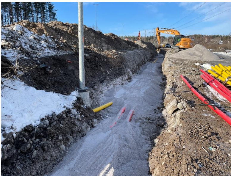
Kuva 5. Valaistus- ja kaapeliputkien asennus käynnissä.
