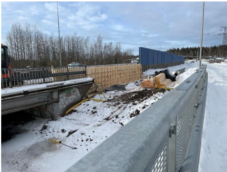
Kuva 4. Askiston tukimuurin lohkon L13 rakentaminen käynnissä.
