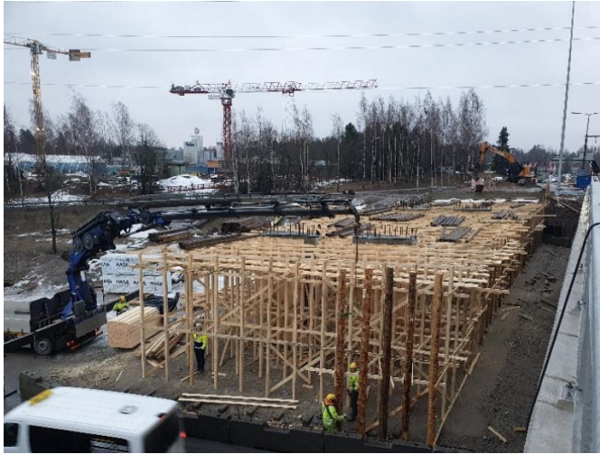
Kuva 1. Sillan S112 aukkopalkkeja tukevien tolpien pystytys käynnissä.
