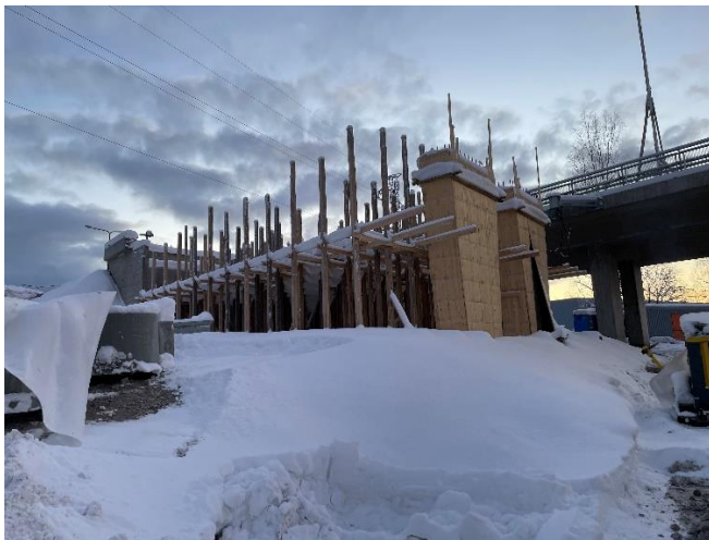
Kuva 3. Sillan S112 telineen rakentaminen käynnissä Kehä III:n eteläpuolella.
