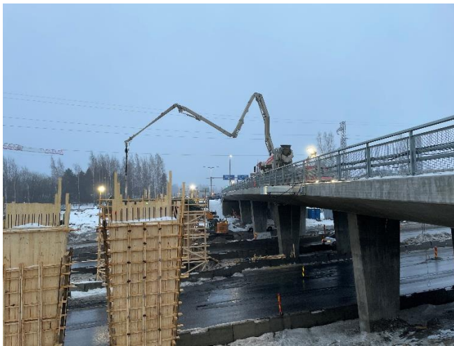
Kuva 2. Sillan S112 tuen T4 pilareiden betonointi käynnissä.
