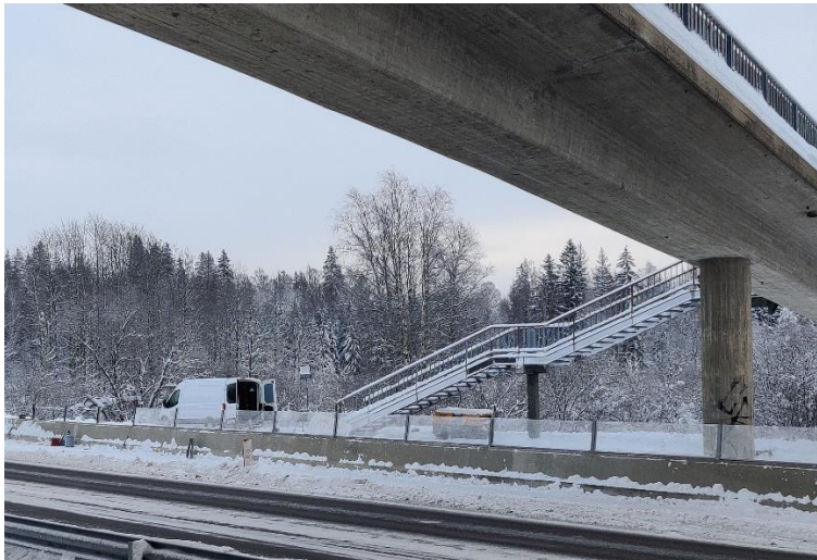
Kuva 4. Askiston ylikulkusillan portaat asennettu ja melukaiteen lasiosien asennus käynnissä.
