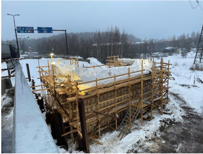
Kuva 1. Sillan S112 maatuki (T6) betonoitu ja jälkihoito käynnissä.
