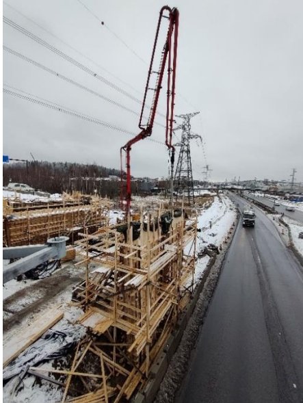
Kuva 2. S112 tukien rakentaminen käynnissä Kehä III:n pohjoispuolella.
