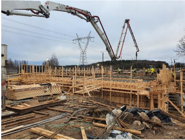
Kuva 1. Sillan S104 betonointi käynnissä viikolla 46.
