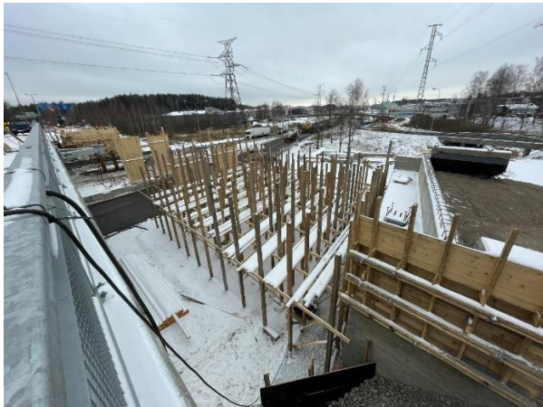
Kuva 3. Sillan S112 telineen rakentaminen käynnissä Kehä III:n eteläpuolella.
