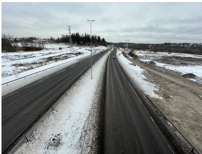
Kuva 5. Yleiskuva sillalta S106 länteen.
