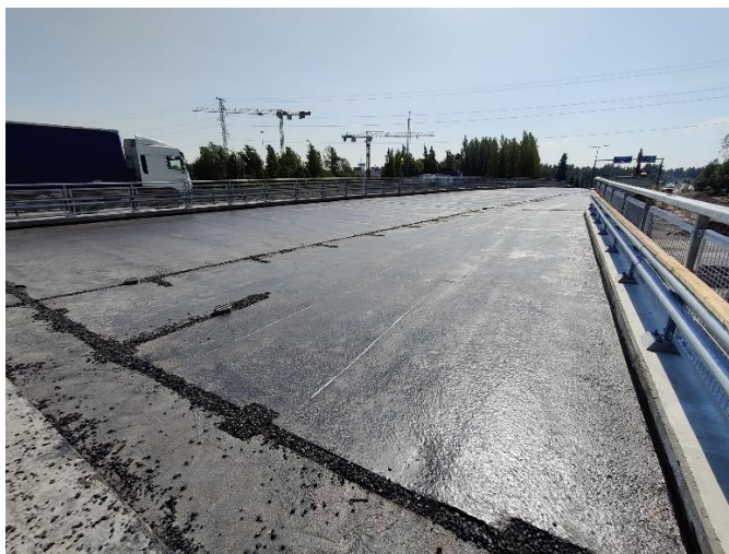
Kuva 3. Silta S111 päällystekerroksia vaille valmis. Silta avattiin liikenteelle 30.6.
