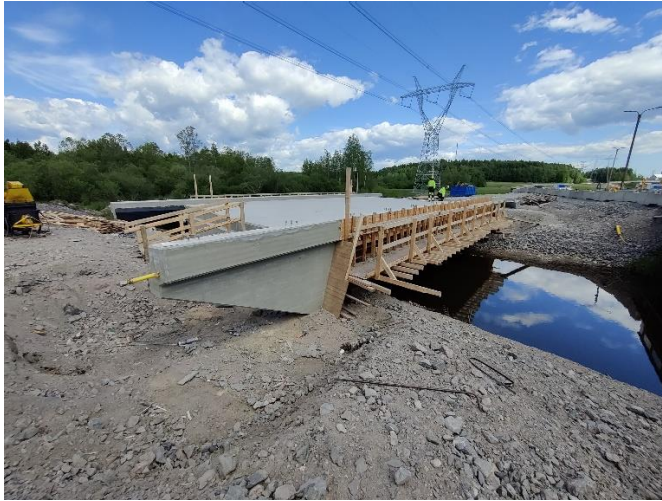
Kuva 1. Sillan S105 muottien purkutyo käynnissä.
