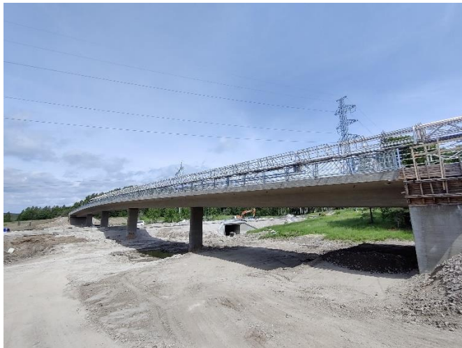
Kuva 2. Sillan S106 sääsuojan rakentaminen käynnissä.
