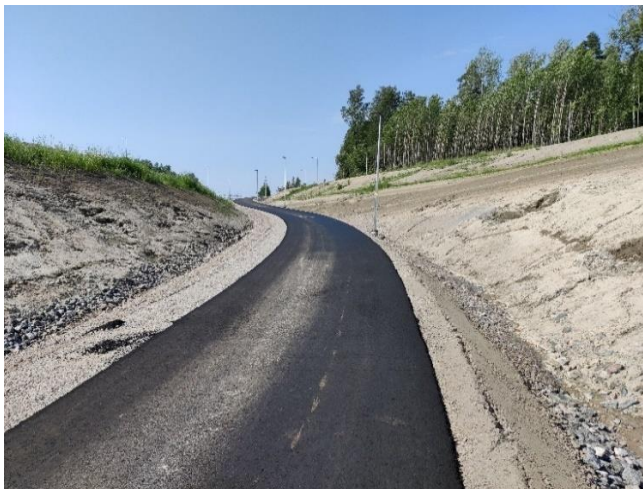
Kuva 5. Siltojen S101 ja S102 alta kulkeva kevyen liikenteen väylä (J1) asfaltoitu.
