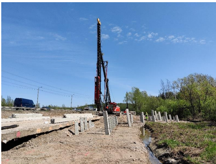
Kuva 5. Paalutus käynnissä paalulaatan S104 kohdalla.
