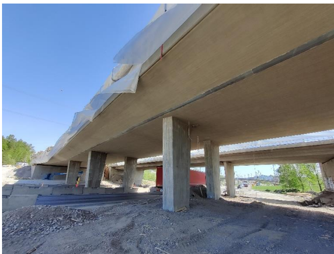
Kuva 3. Sillan S111 kansi betonoitu ja muotit purettu.
