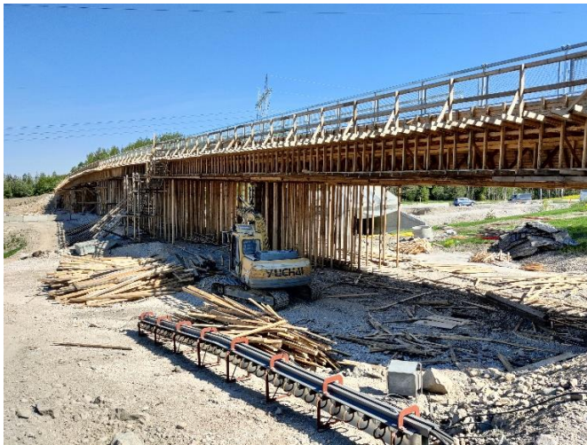
Kuva 2. Sillan S106 telaineiden ja muottien purkutyöt käynnissä.
