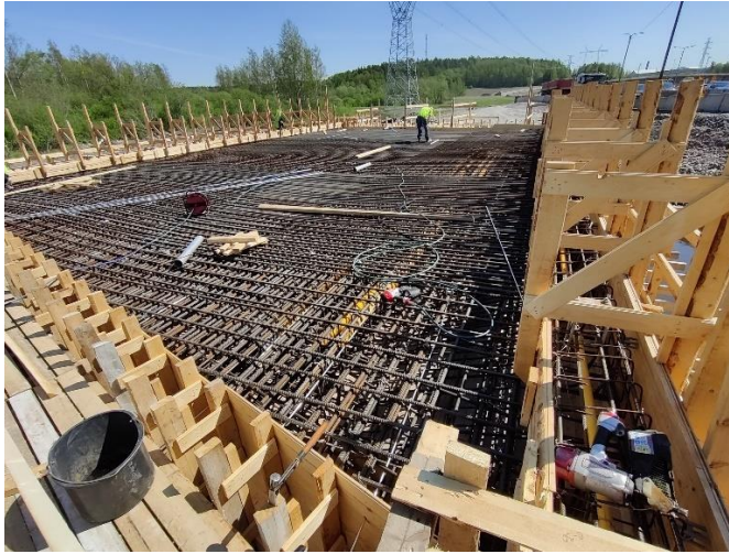
Kuva 1. Sillan S105 raudoitustyöt käynnissä.
