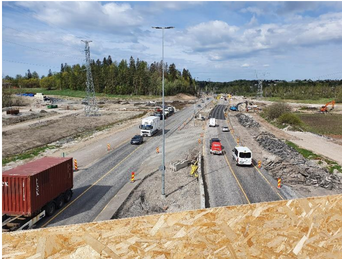
Kuva 4. Yleiskuva sillalta S106 länteen.
