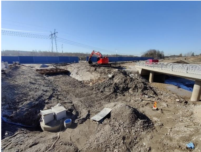
Kuva 4. Väylän J2 pumppaamo asennettu ja rakennekerrosten teko sekä luiskien viimeistely käynnissä.
