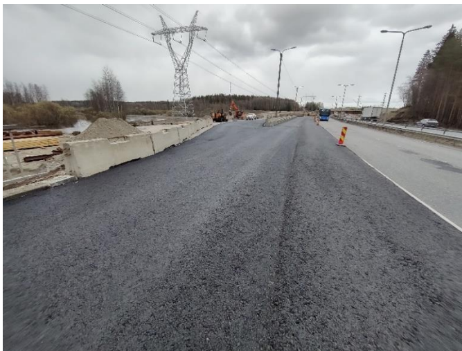
Kuva 5. Valmistunutta päällystystä S104 kiertotien kohdalla.
