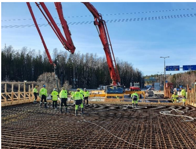
Kuva 3. Sillan S111 kannen betonointi käynnissä.
