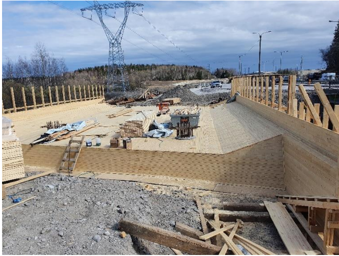
Kuva 1. Sillan S105 muotin rakentaminen käynnissä.
