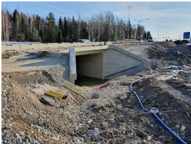
Kuva 2. Sillan S107 levitysosa betonoitu ja muotit purettu.
