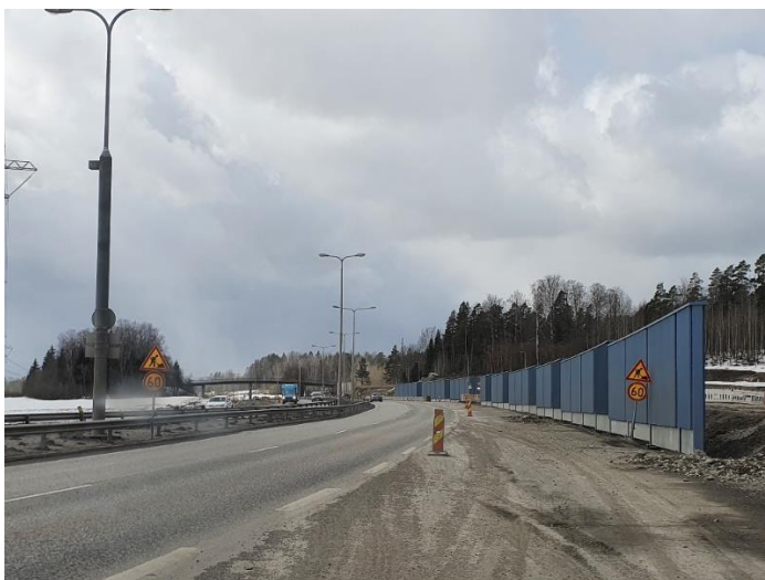
Kuva 5. Meluseinät pystytetty Askiston kohdalla.
