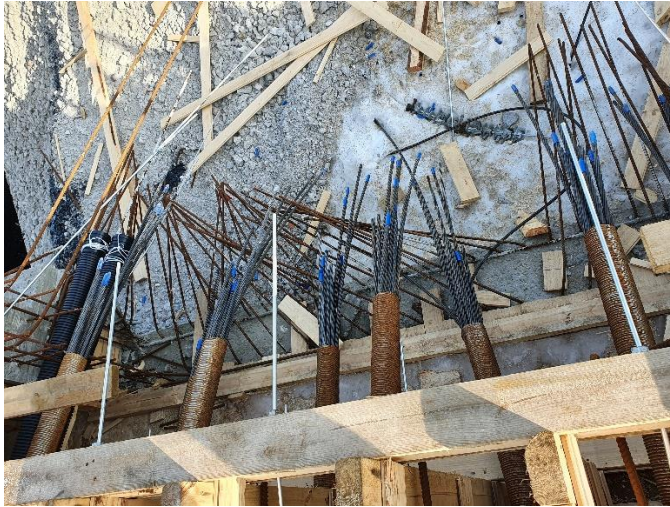
Kuva 1. Sillan S106 jännitysteräket asennettu.
