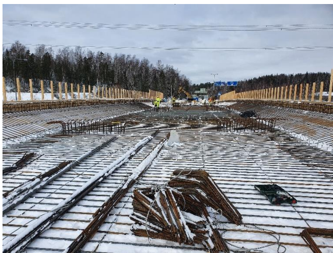
Kuva 3. Sillan S111 siltakannen raudoitus käynnissä.
