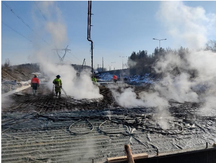
Kuva 4. S105 paalulaatan höyrytys ja valu käynnissä.
