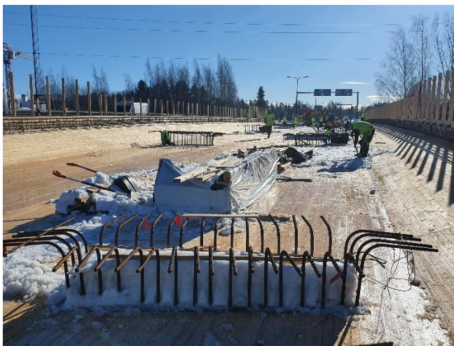
Kuva 3. S111 siltakannen lumityöt käynnissä ja rauditus alkamassa.
