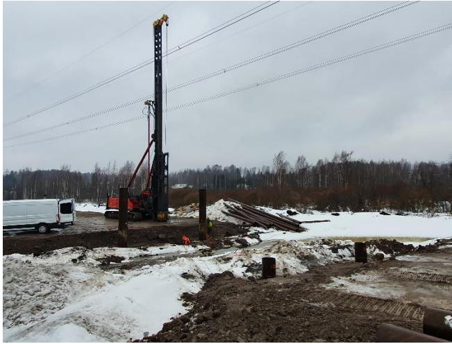
Kuva 1. Sillan S105 paalutus käynnissä Pikkujärvenojan kohdalla.
