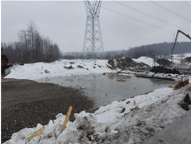
Kuva 4. S105 paalulaatan yläpuolisten rakennekerrosten rakentaminen käynnissä.
