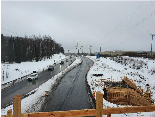
Kuva 2. Yleiskuva sillan S106 kannelta itään. Kuvan oikeassa alakulmassa S107 rauditustyöt käynnissä.
