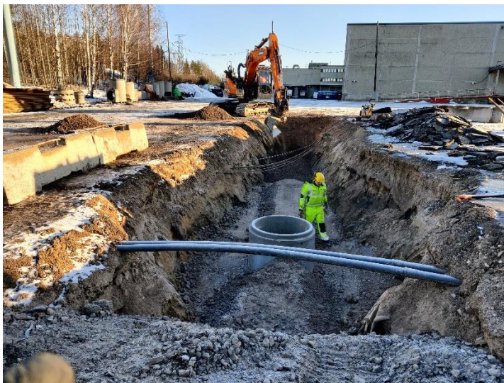
Kuva 5. Vesihuollon rakentaminen käynnissä väylällä K2 Ainontien varaston kohdalla.
