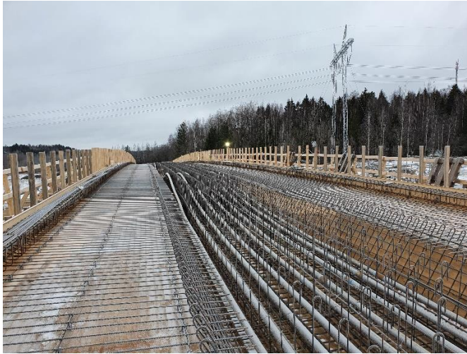
Kuva 1. S106 siltakannen rauditus käynnissä.
