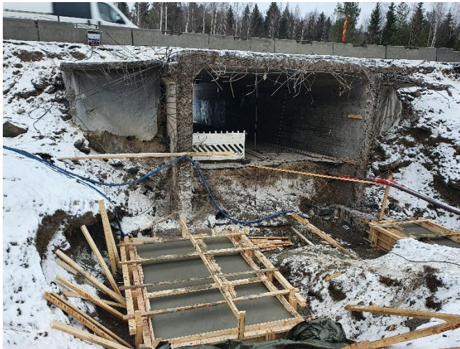
Kuva 2. Sillan S107 anturat valettu.
