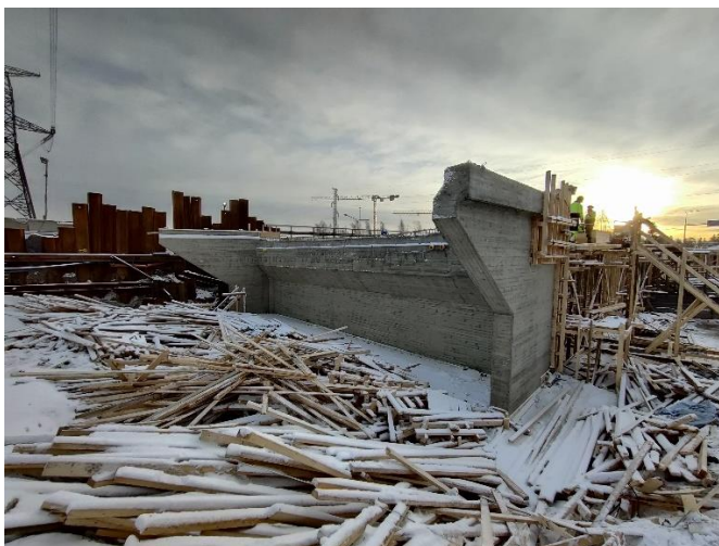
Kuva 3. Sillan S111 maatuen T6 muotit purettu. Kansimuotin teko käynnissä.
