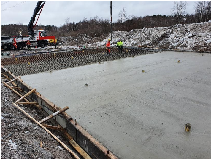
Kuva 4. S105 paalulaatan valu käynnissä väylällä K2.
