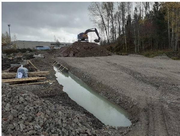
Kuva 4. Askistossa rakennekerrosten teko käynnissä väylällä K3.
