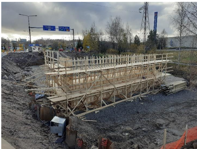
Kuva 3. Sillan S111 eteläpuolen maatumien rakentaminen käynnissä. Taustalla paalulaatan paalutus valmistunut.
