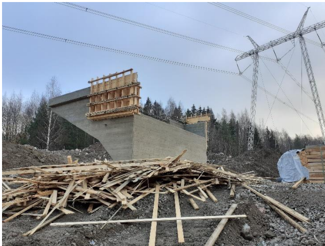
Kuva 2. Sillan S106 T1 muottien purku käynnissä.
