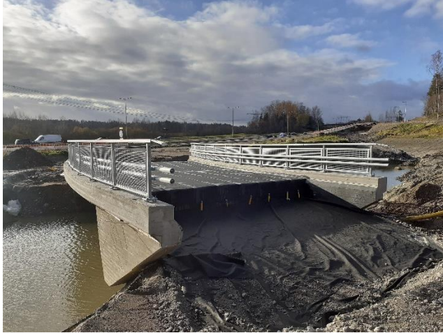
Kuva 1. Sillan S101 vedeneristys tehty ja sääsuoja purettu.
