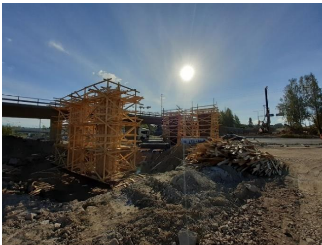
Kuva 3. Sillan S111 maatukien rakentaminen käynnissä.
