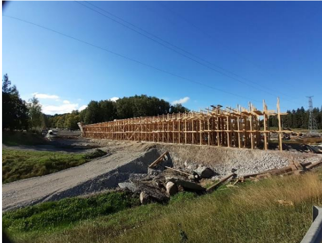
Kuva 1. Sillan S106 teline- ja muottityöt käynnissä.
