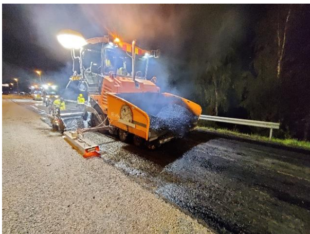
Kuva 5. Vantaankoski-Pakkalassa päällystystyöt käynnissä.
