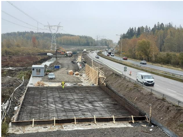
Kuva 4. Askistossa väylän K2 paalulaatan raudoituksen viimeistely käynnissä.
