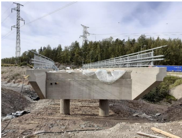
Kuva 2. Sillan S108 muotit purettu ja kaiteiden asennus käynnissä.
