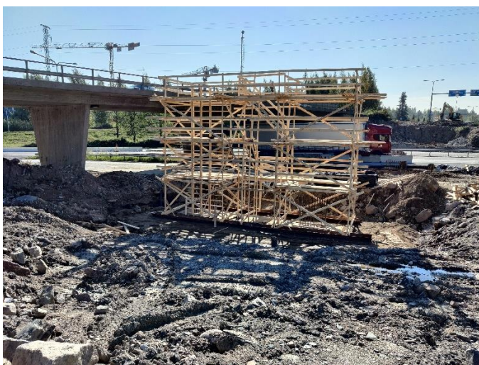
Kuva 3. Sillan S111 välitukien rakentaminen käynnissä.
