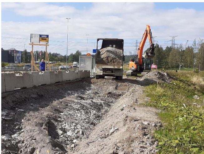
Kuva 5. Vantaankoski-Pakkalassa rakennekerrosten teko käynnissä. Pysäkki siirretty väliaikaisesti kaivuutöiden edestä.
