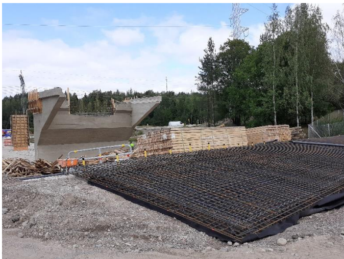
Kuva 2. Sillan S106 tuet T5 ja T6 valettu ja siirtymälaatan raudoitustyöt käynnissä.
