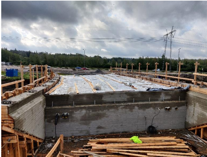
Kuva 1. Sillan S102 jälkihoito sekä muottien purku käynnissä.
