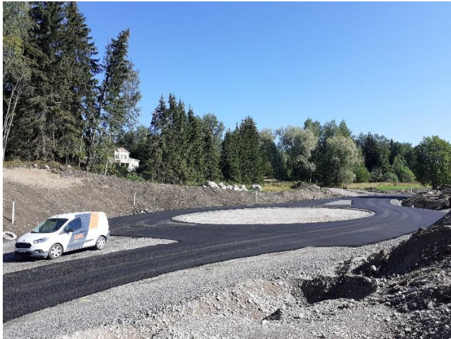
Kuva 4. Askistossa Uudenkyläntien uusi linjaus asfaltoitu. Liikenteensirron valmistelu käynnissä.
