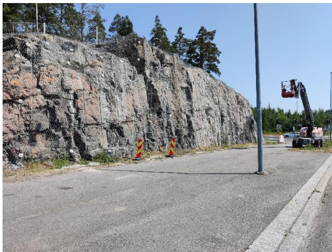
Kuva 5. ELY:n kalliorusnauksen muutostyötilaus. Rusnaustyöt ovat valmiit, pultitus- ja verkostustyöt ovat käynnissä.
