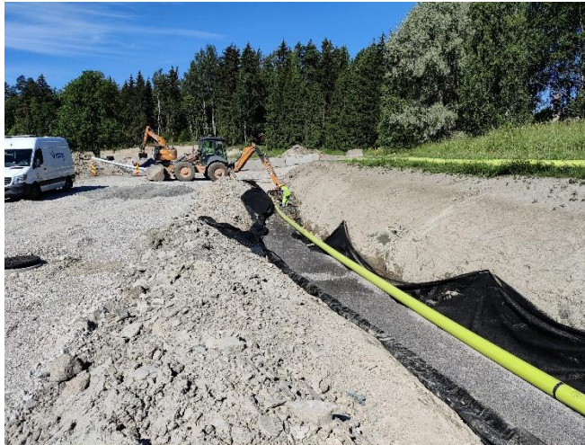
Kuva 4. Uudenkyläntien uuden kaasuputkilinjan rakentaminen käynnissä.
