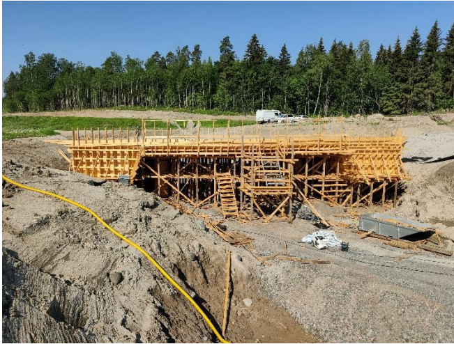
Kuva 1. Sillan S101 kansimuotti saatu valmiiksi. Raudoituksen teko aloitettu.
