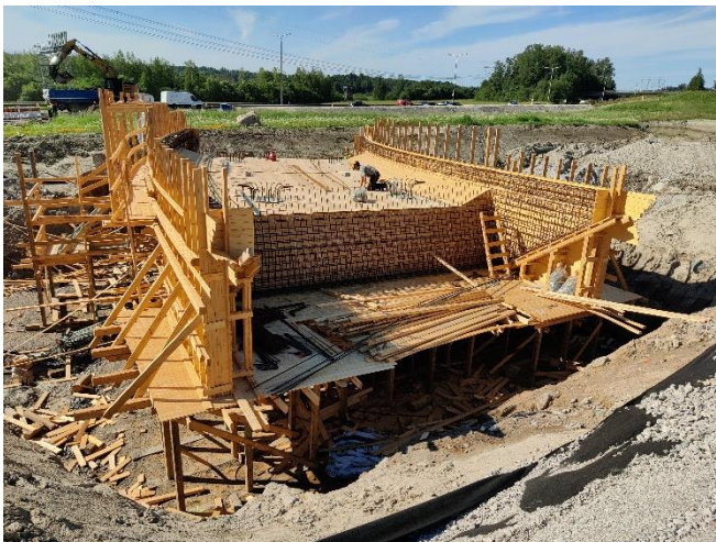
Kuva 2. Sillan S102 kansimuotin teko käynnissä.
