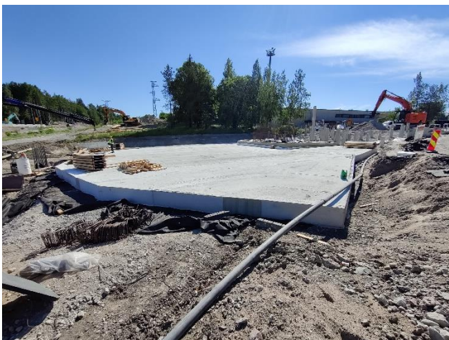
Kuva 3. Sillan S106 ensimmäinen paalulaatta valettu.
