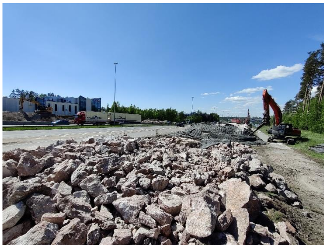
Kuva 4. Louhintatyöt ja maaleikkuu käynnissä Vantaankoski-Pakkala hankeosa-alueella.
