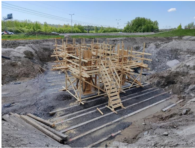
Kuva 1. Silta S101 teline- ja pilarimuottityöt käynnissä Askiston hankeosa-alueella.
