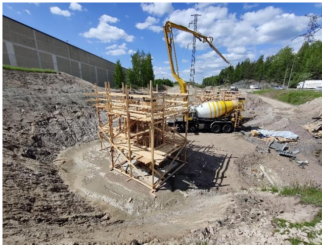
Kuva 2. S108 pilareiden valutyö käynnissä Askiston hankeosa-alueella.
