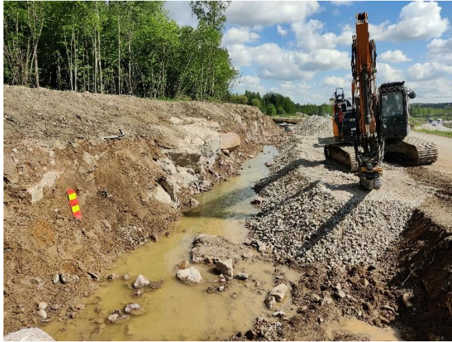
Kuva 3. Gasgridin kaasuputken kanaalin rakentaminen käynnissä Uudenkyläntiellä.
