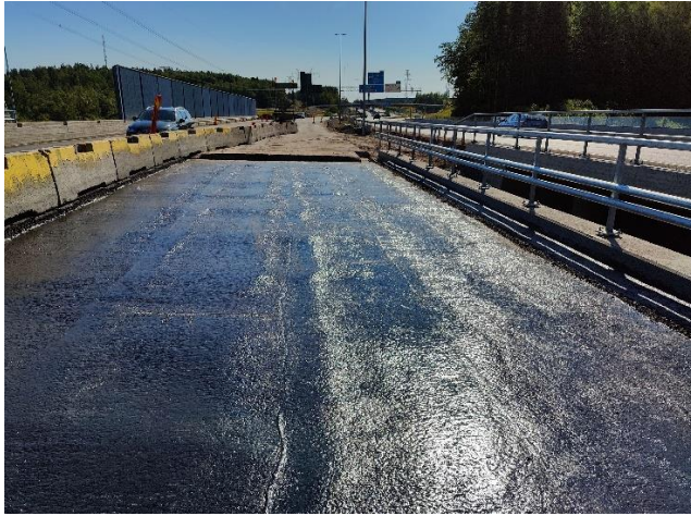
Kuva 1. Sillan U-950 kansi eristetty. Silta on päällystetty ja avattu kokonaisuudessaan liikenteelle viikolla 28.
