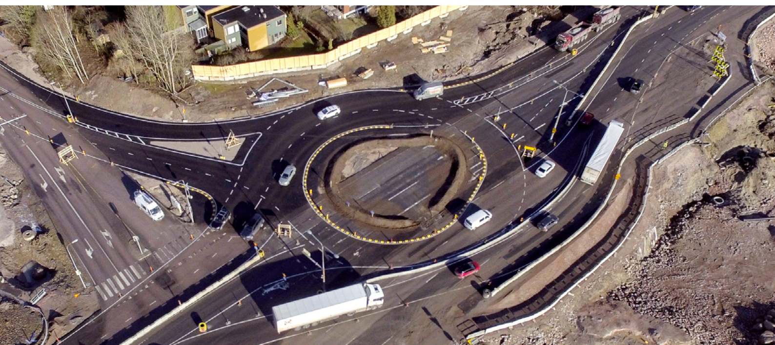
Rondellen vid Ring I och Torvmossvägen medan arbetena pågår
