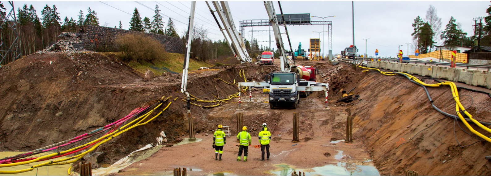
Borrpålar för bron över tunneln vid Bruksstranden
