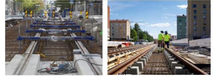
Kuva 11.3:1. Vasemmalla kiskot on tuettu jatkuvasti ja oikealla pistemäisesti [11].
