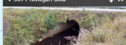
V-5071 Kiviojan silta
