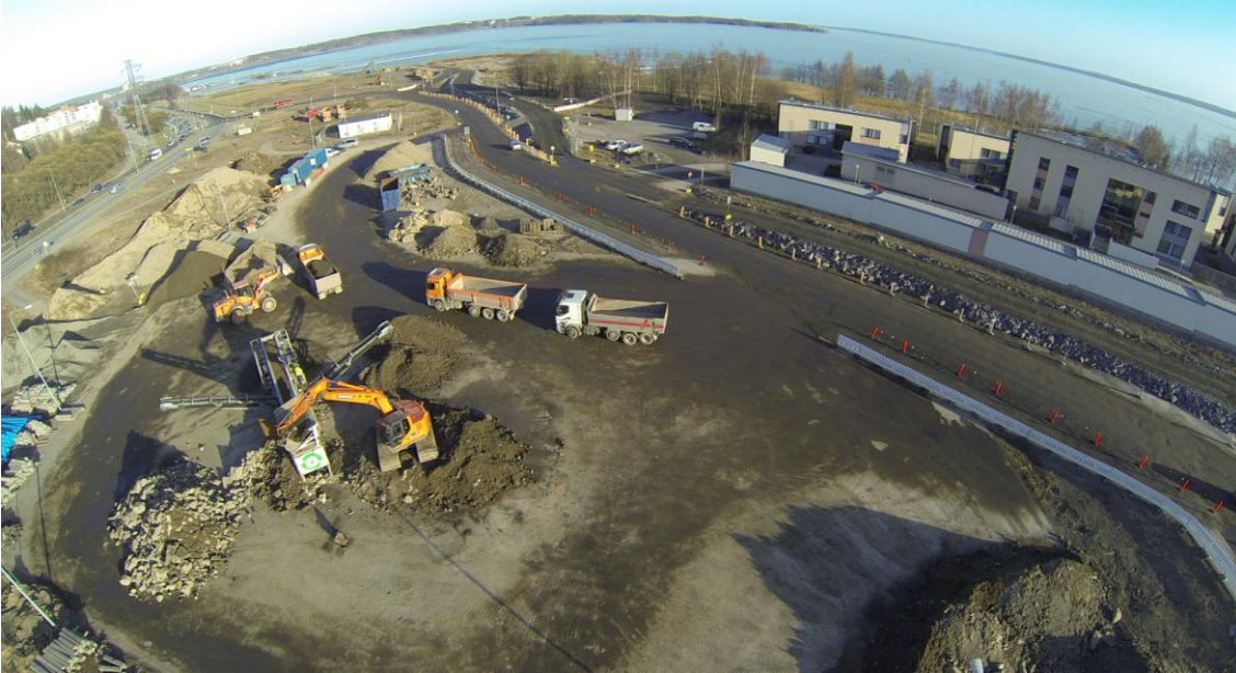
Kuva 3.5. Tunnelityömaa Santalahden mittausaseman läheisyydessä maaliskuussa 2014. Mittausasema sijaitsee asuinrakennusten vasemmalla puolella kuvan ylä laidassa. Kuva: Rantatunnelin allianssi.
