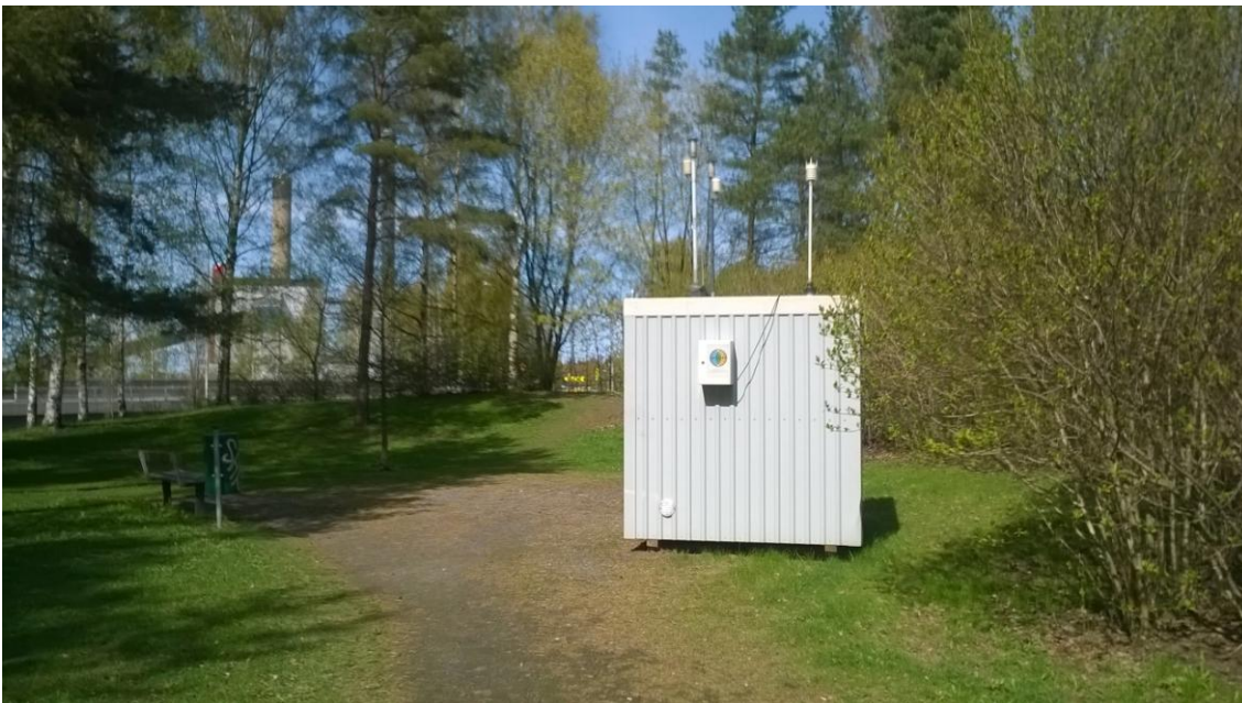
Kuva 3.2. Naistenlahden ilmanlaadun mittausasema toukokuussa 2014. Kuva: Kaj Lindgren, Ilmatieteen laitos. Kuvassa taka-alalla näkyy Tampereen sähkölaitoksen Naistenlahden voimalaitos.
