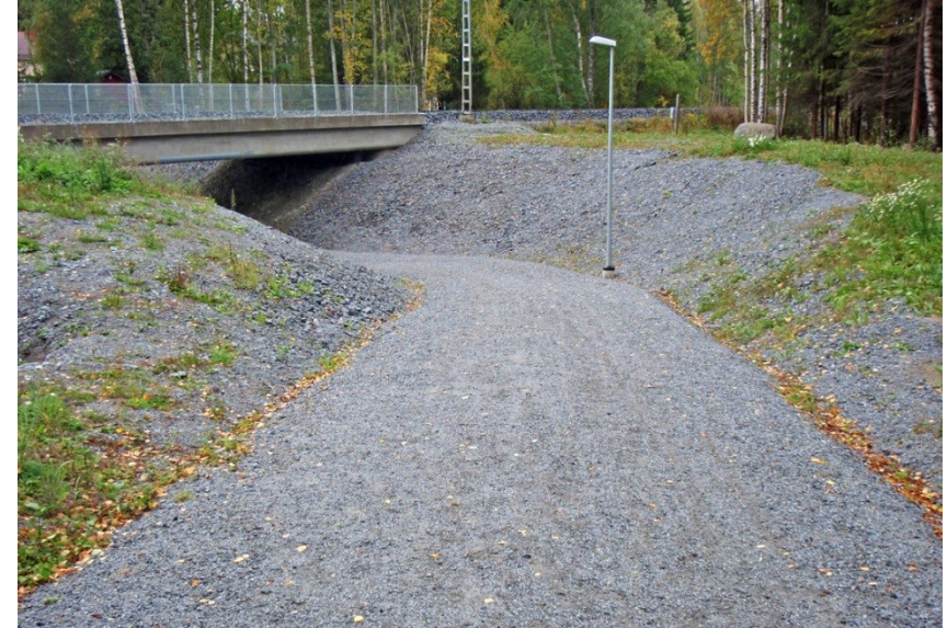
Uusi alikulkusilta, Harjuniitty, Nokia
