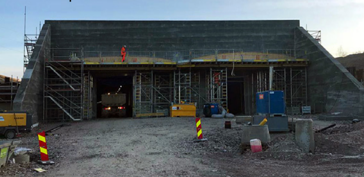
Otsapalkit alkavat valmistua Patomäen tunnelilla.
