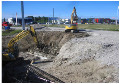
Menossa Hankaankadun risteyssillan kohdan kiertotien purku.
