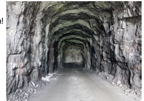
Ensimmäisen tutkimustunnelin louhinta on edennyt hyvin.
