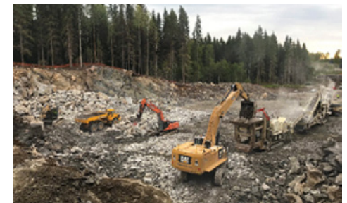
Kiviaineksen murskaus käynnissä Kujalassa.
