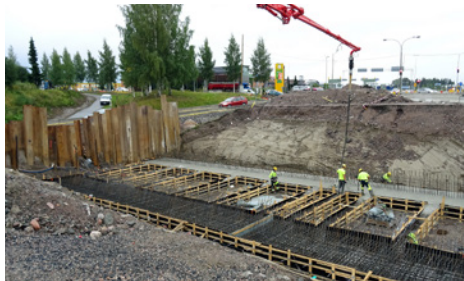
Kyöstilän alikulkukäytävän peruslaatan raudoitustyöt ovat valmistumassa.
