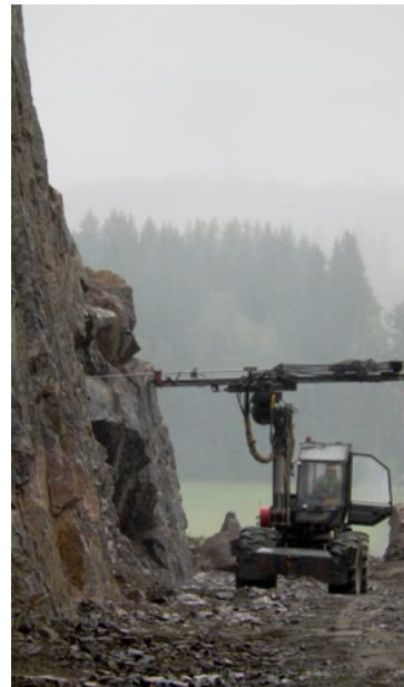
Kuvassa Patiokallion lujitustyöt.
