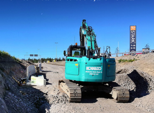
Tukimuuria Patomäen alikulkukäytävän kohdalla.
