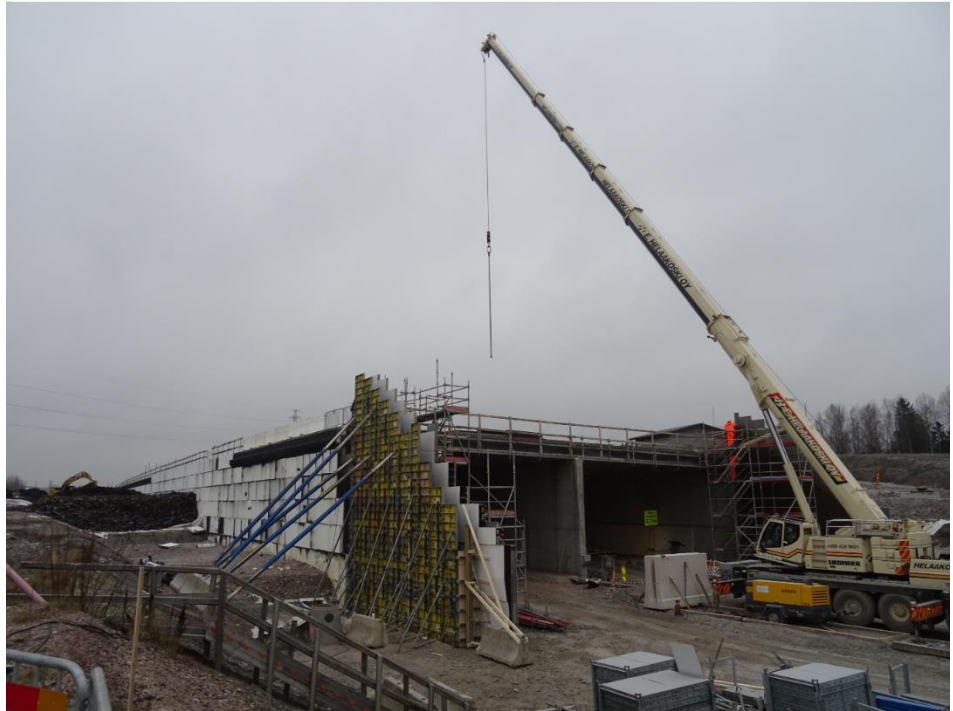
Kuva 3. Patomäen tunnelin itäinen suuaukko, vasemmalla rengasleikekevennyks
