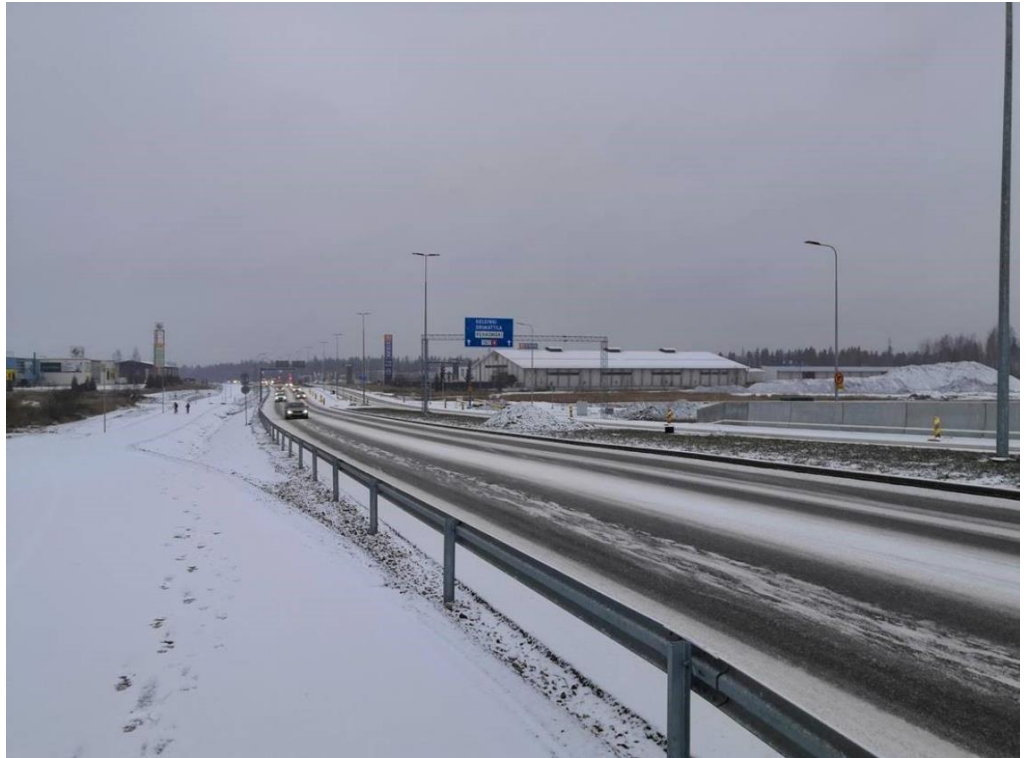
Kuva 5. Uusi avattu kävelyn ja pyöräilyn väylä Launeen risteys sillan ja Aukeankadun välillä
