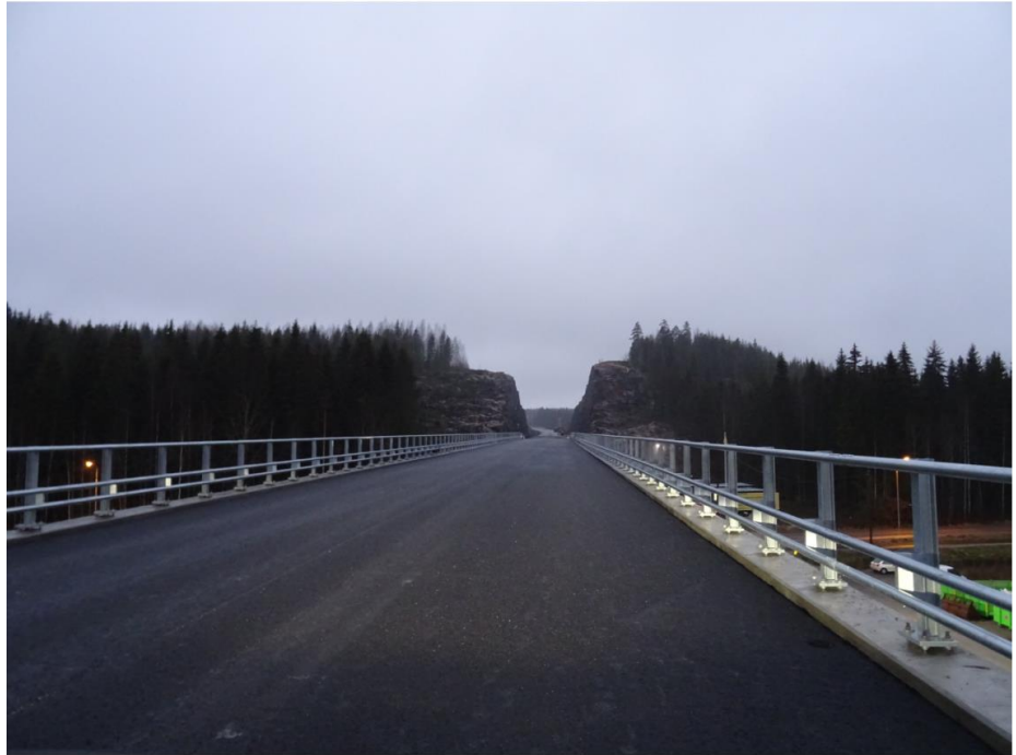
Kuva 1. Luhdanjoen silta sai kaiteet ja päällysteen pintaansa
