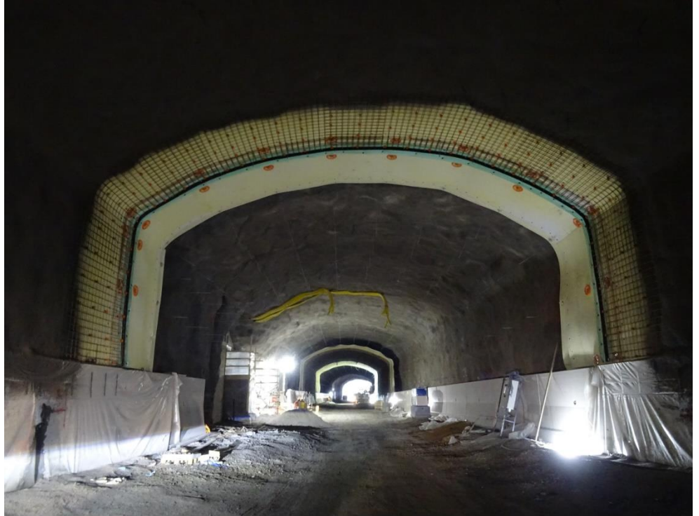
Kuva 4. Liipolan tunnelin verhousrakennetta
