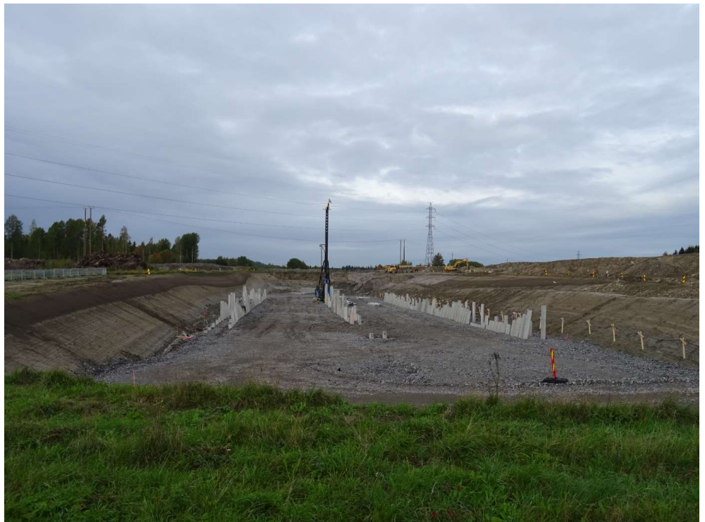
Kuva 3. Patomäen tunnelin itäpään paalutus käynnissä
