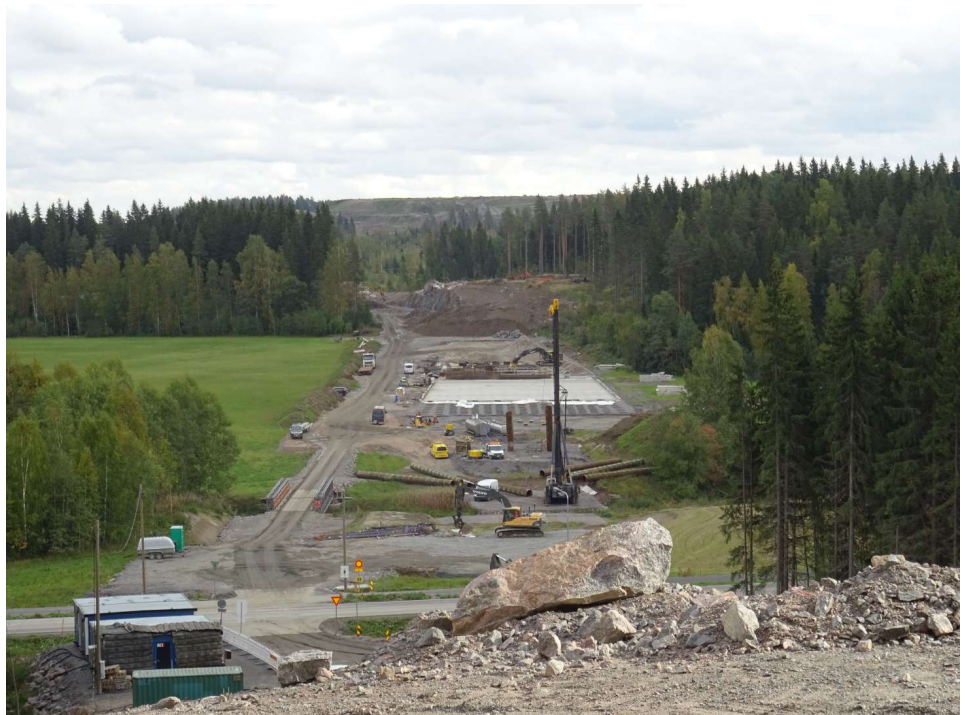
Kuva 2. Tielinjaa Patiokalliolta länteen, Vähäjoen risteys sillan paalutus ja paalulaattojen rakentaminen käynnissä
