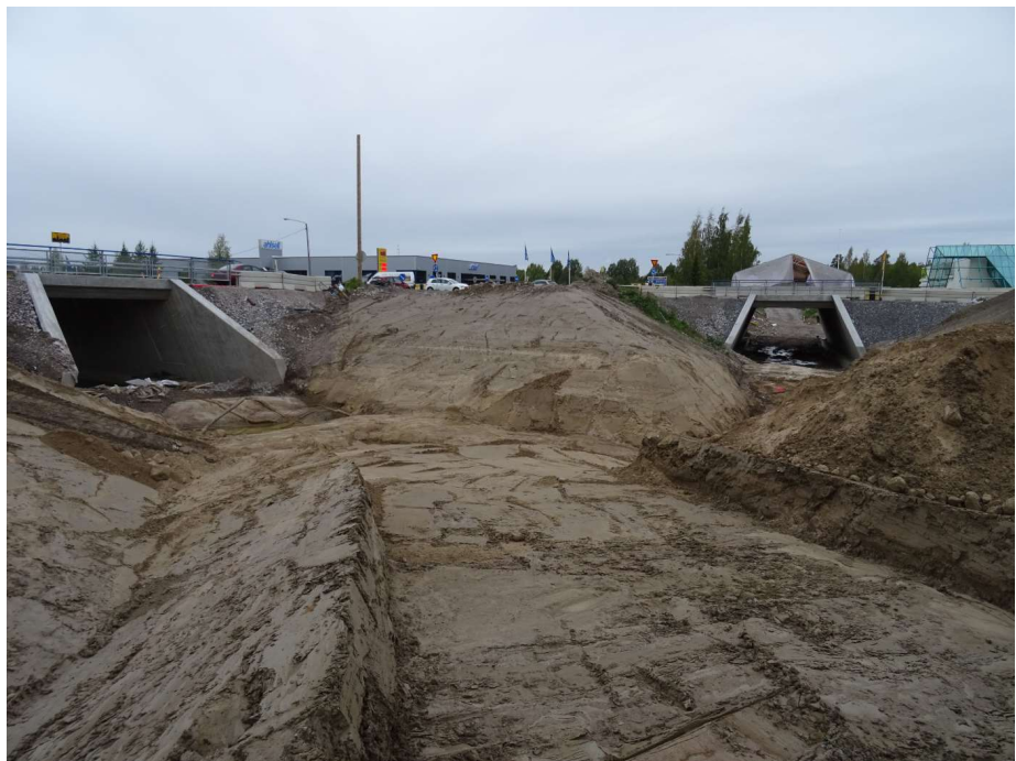
Kuva 6. Orimattilankadun ja Kangasmäen alikulkukäytävät ja niille johtavan kevyen liikenteen väylän kaivutyöt
