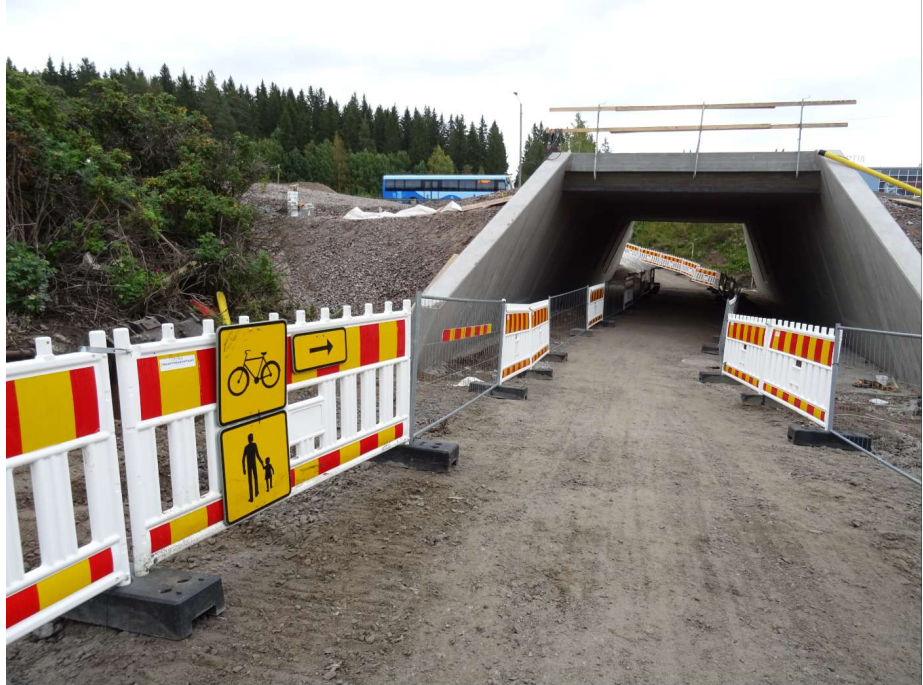
Kuva 5. Tasangonpolku uuden Patomäen alikulkukäytävän ali
