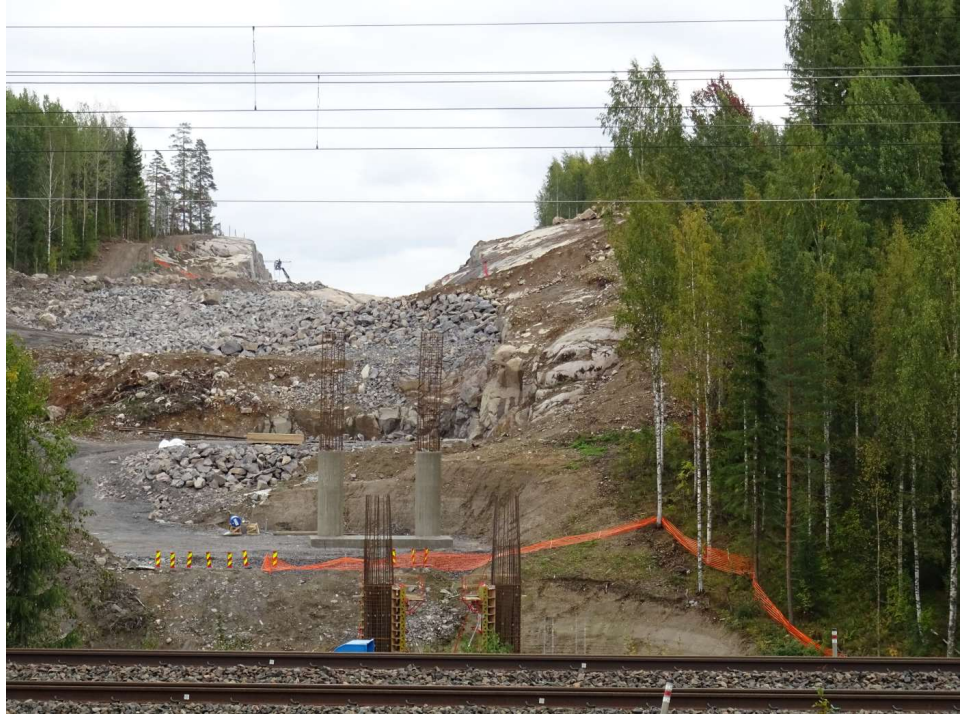
Kuva 1. Vähäjoen ylikulkusillan välitukia ja lujitusta Patiokalliolla
