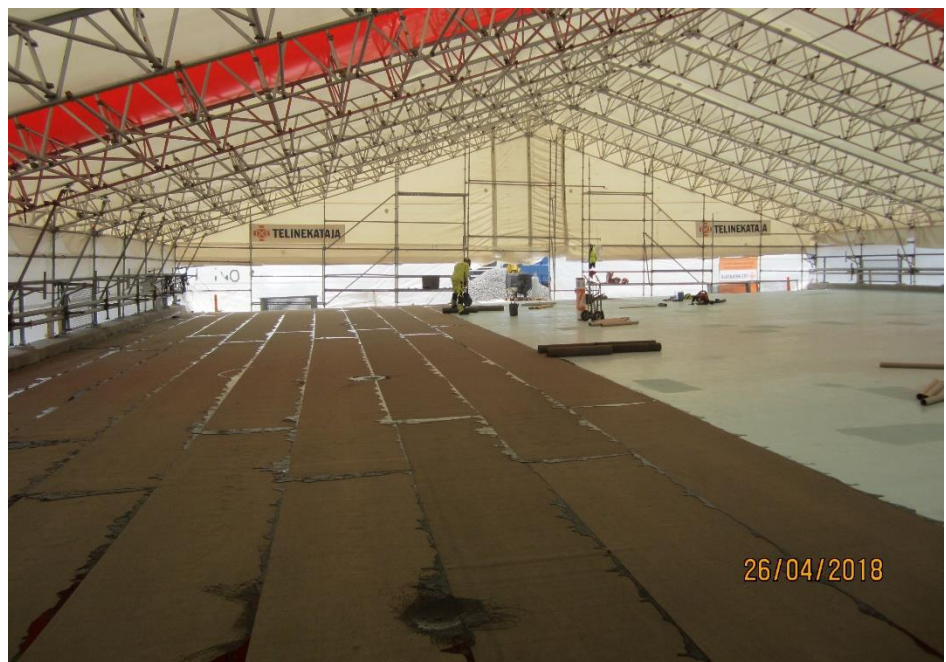
Kuva 5. Hankaankadun risteyssillan (S1) kermieristys
