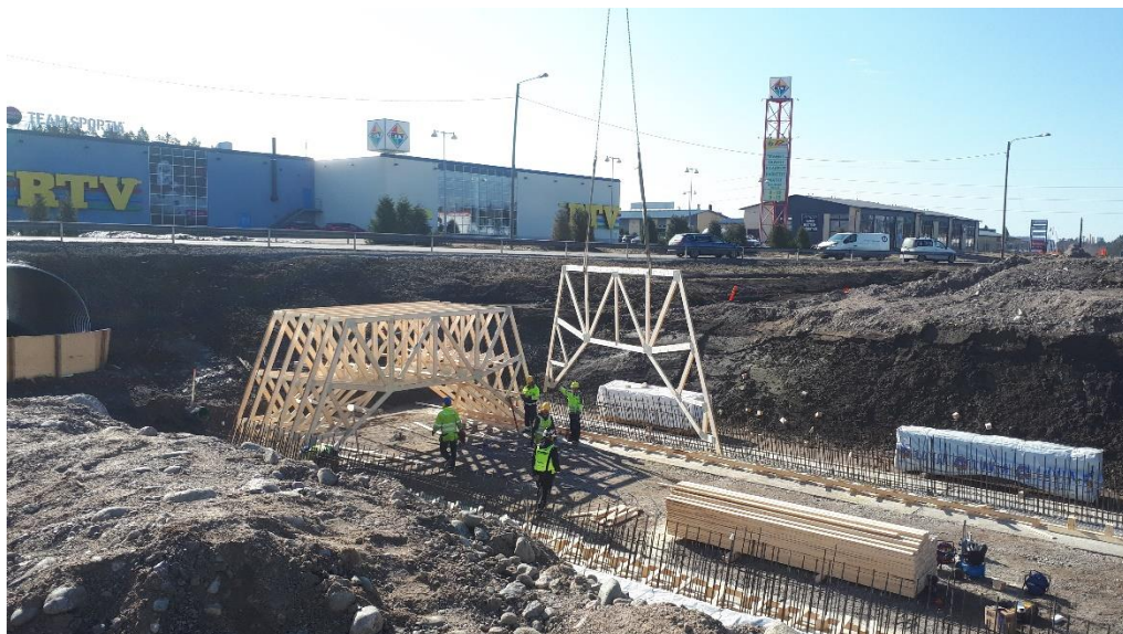
Kuva 6. Patomäen alikulkukäytävän (S36) telinepukkien nosto.
