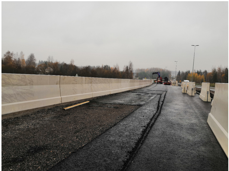
Kuva 6. Melukaiteen asennusta Venetsian kohdalla
