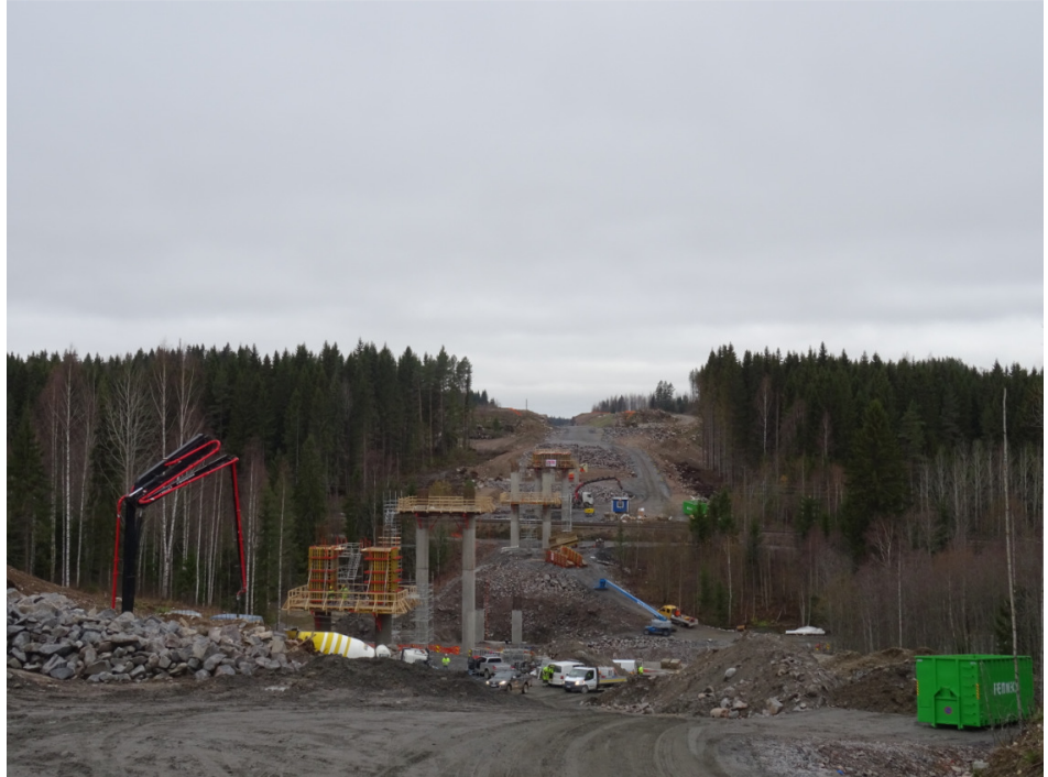
Kuva 1. Vähäjoen ylikulkusilta lännestä päin
