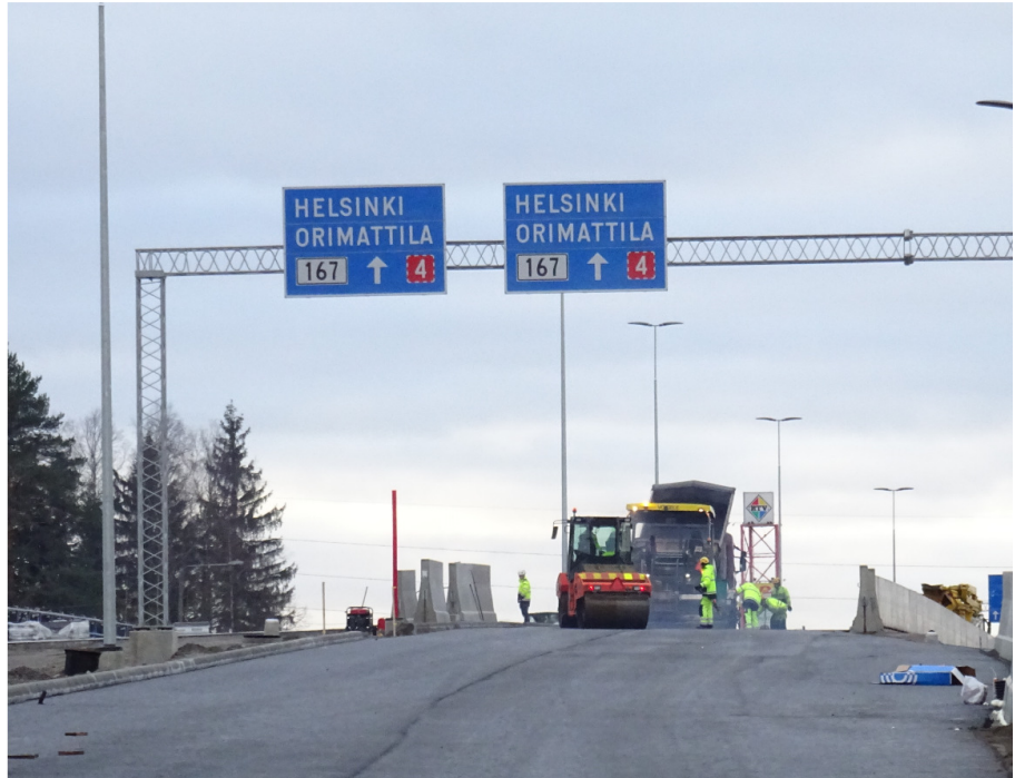
Kuva 5. Launeen risteyssillan päällystystä
