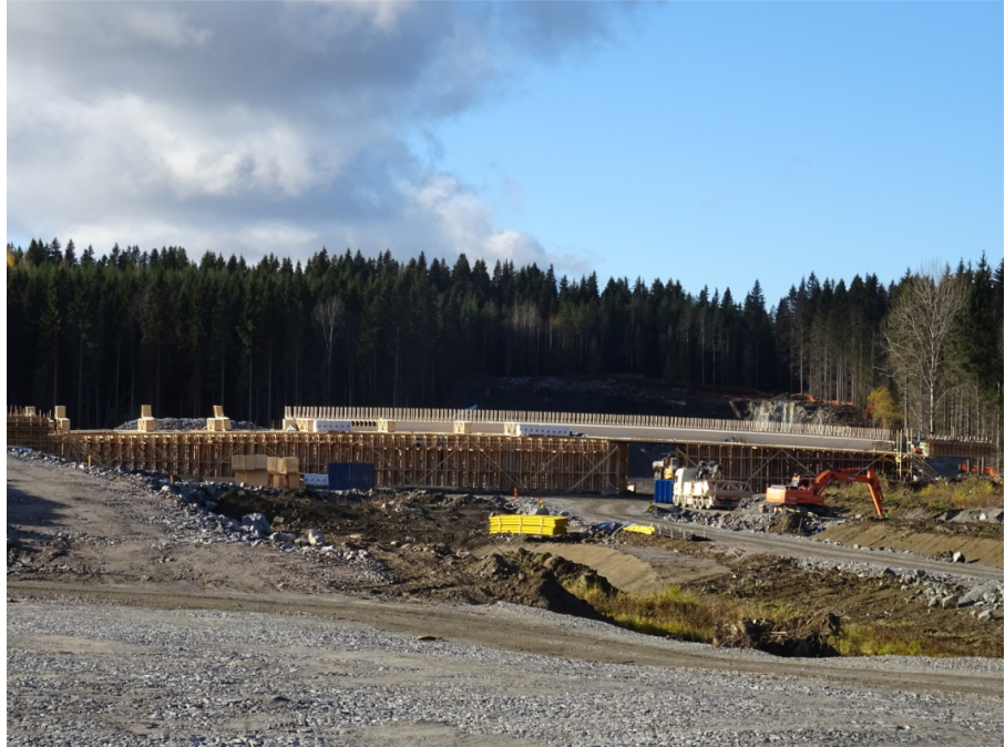
Kuva 4. Huovilanmäen risteysilta Kujalassa
