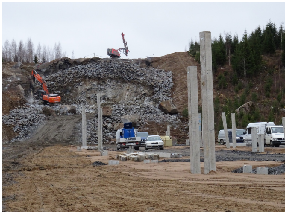
Kuva 2. Louhintaa ja paalutusta Takamaalla
