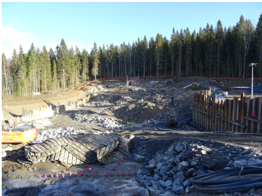
Kuva 3. Louhintatyöt Liipolan välitunnelilla
