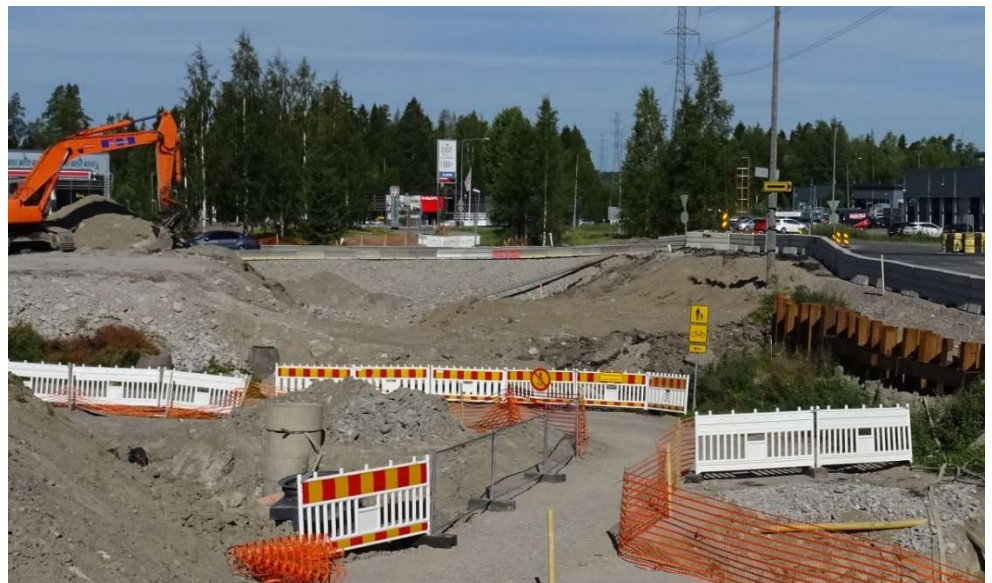
Kuva 6. Kaikki vanhojen alikulkukäytävien purkutyöt on nyt saatu tehtyä. Aukeankadun purettu alikulkukäytävä.
