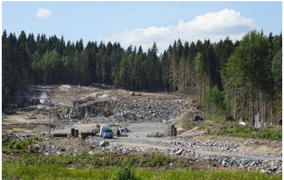
Kuva 3. Liipolan tunnelin itäinen suuaukko Kujalassa.
