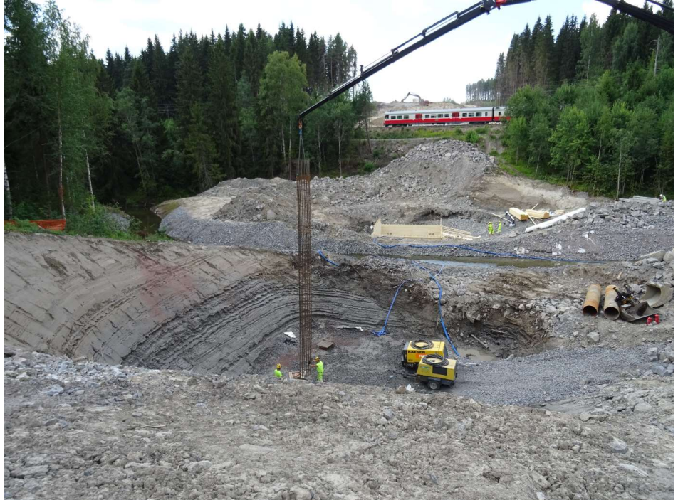
Kuva 1. S7 Vähäjoen ylikulkusillan porapaaluperustusten raudoituksen asennus.
