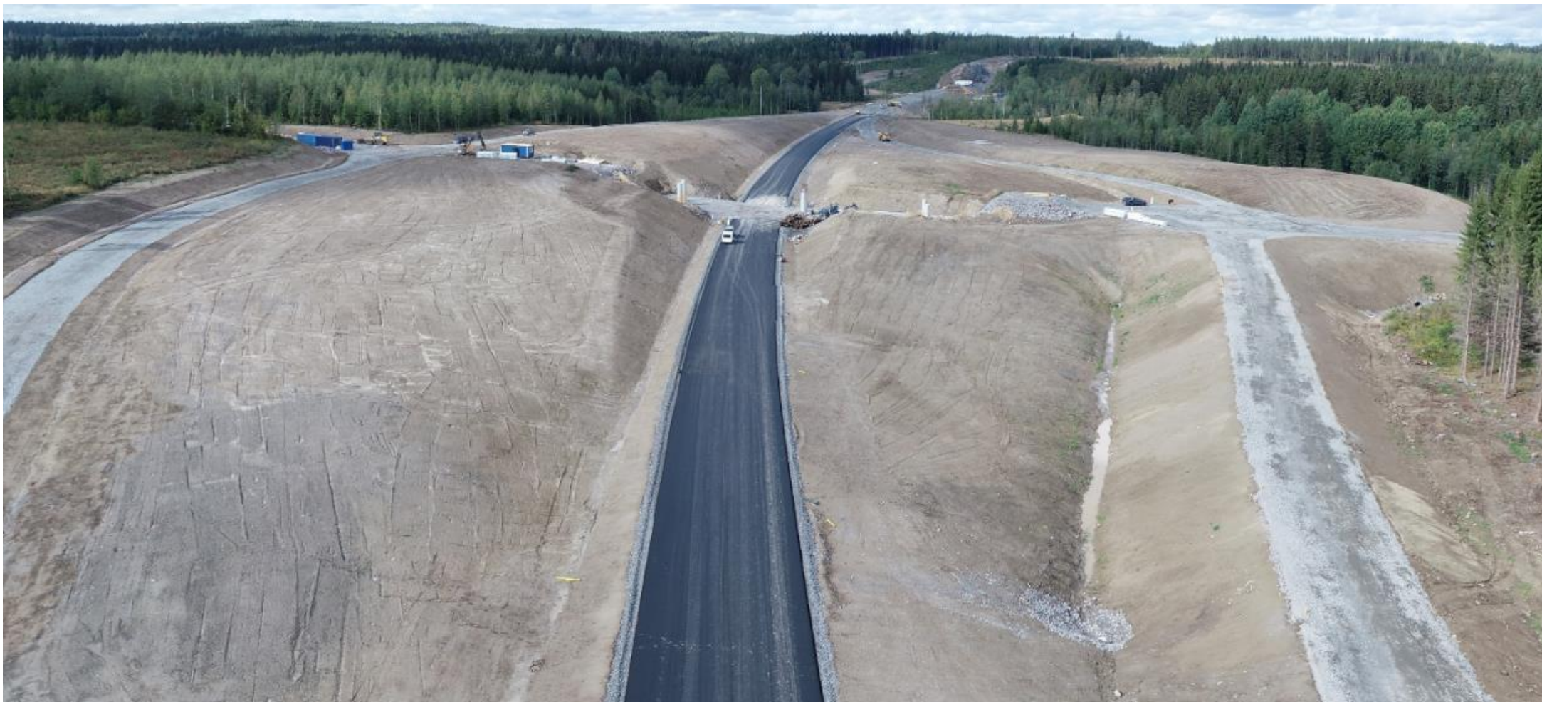
Nostavan eritasoliittymä, näkymä Hollolaan päin
