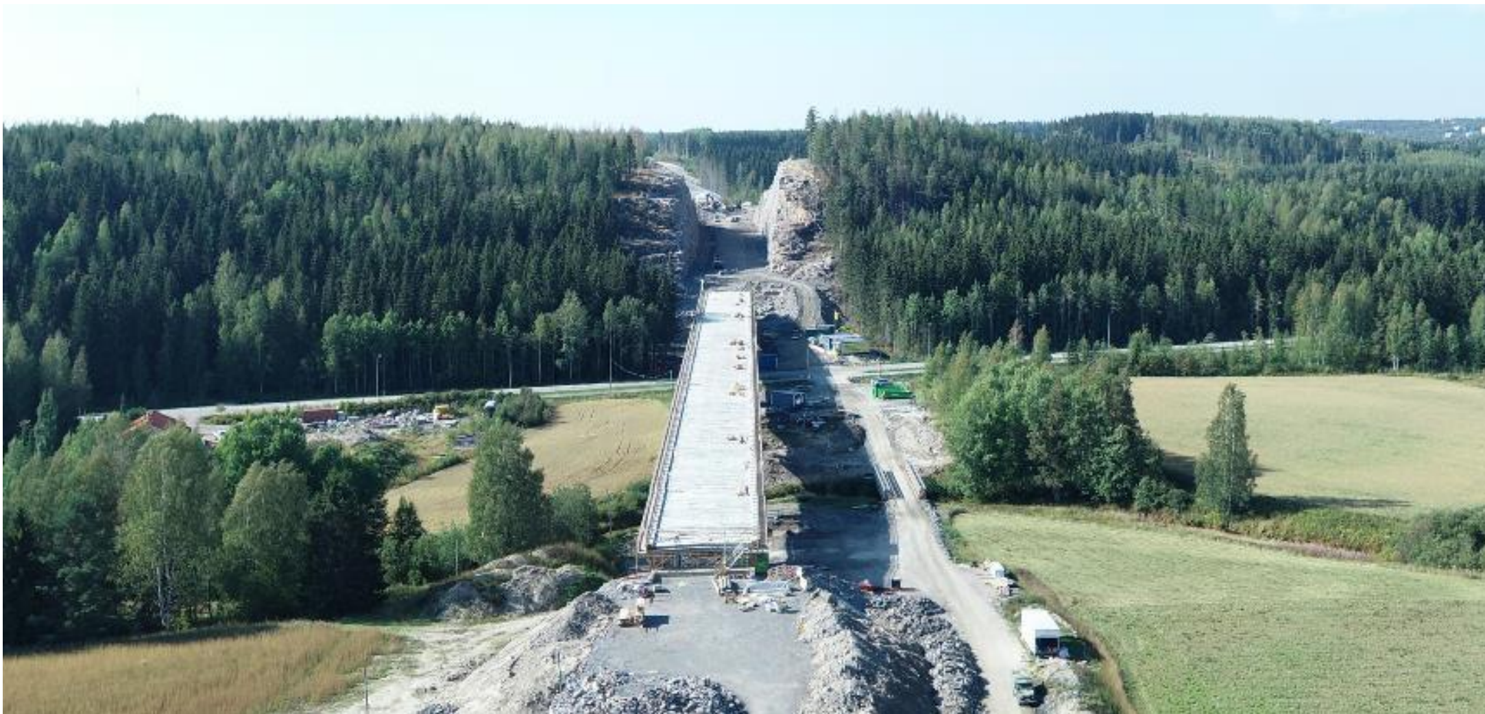
Silta S9 Luhdanjoen silta, näkymä Hollolan suuntaan
