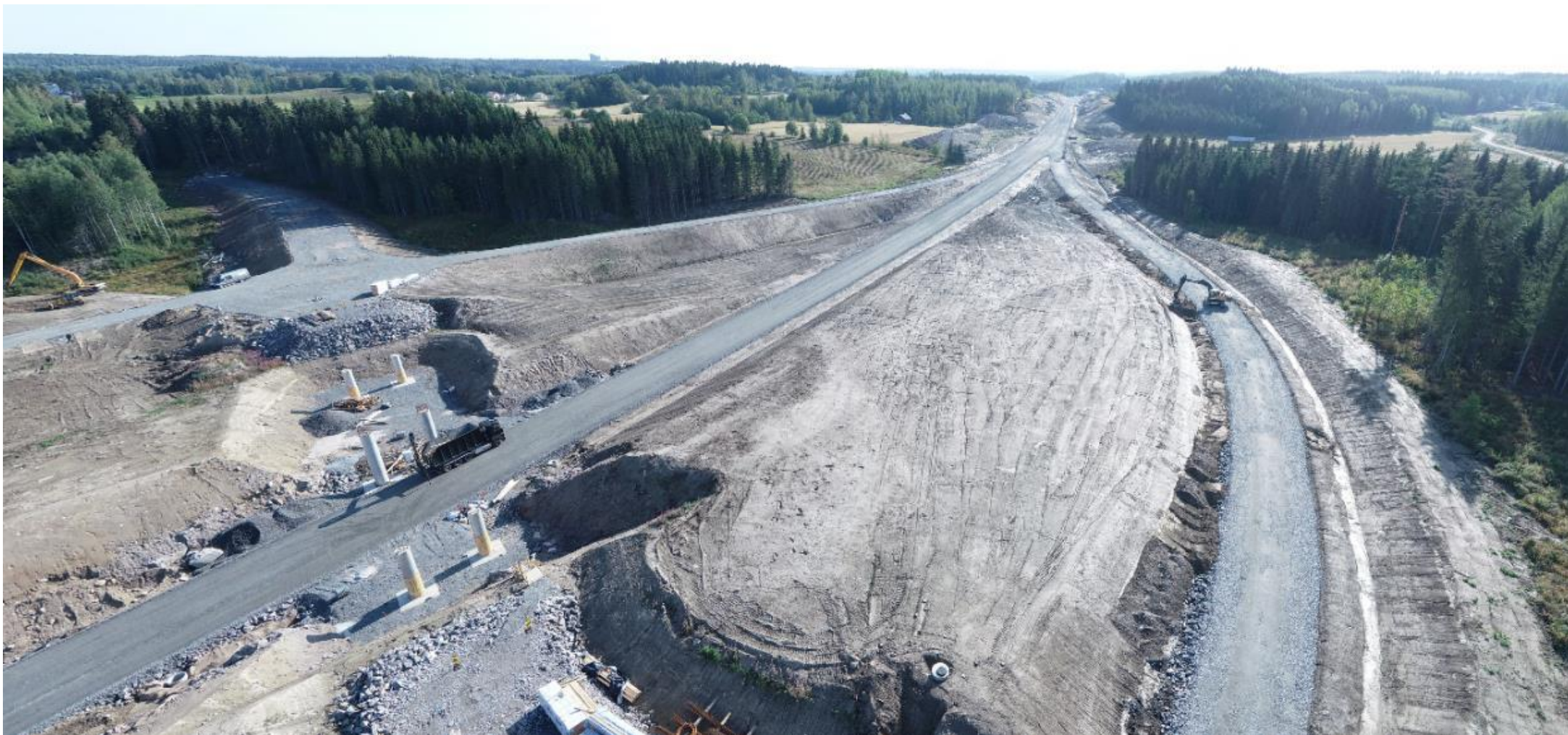
Näkymä Nostavan eritasoliittymästä Tikkakalliontielle päin
