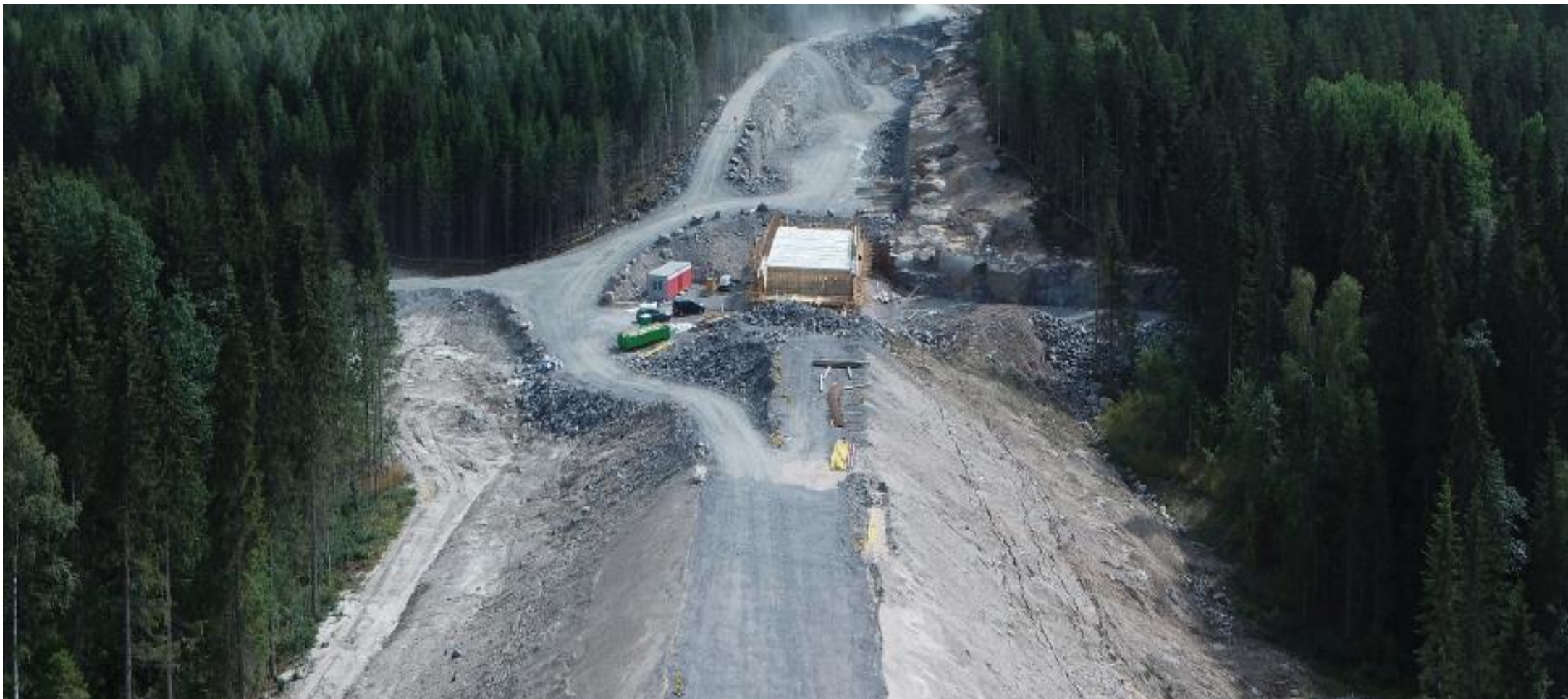
Näkymä sillan S3 Hirvikallion risteyssillan suunnasta Lahteen
