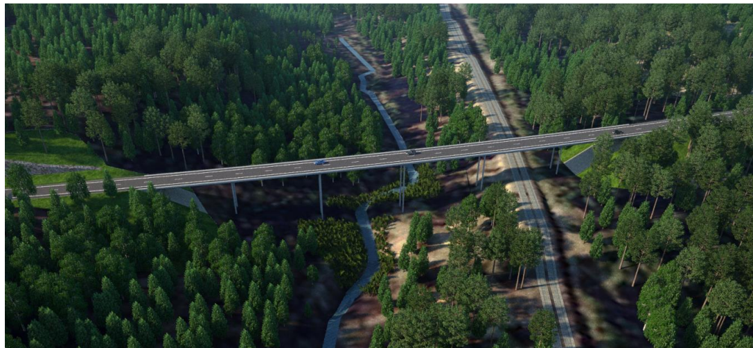
S7b Vähäjoen ylikulkusilta pohjoisesta
