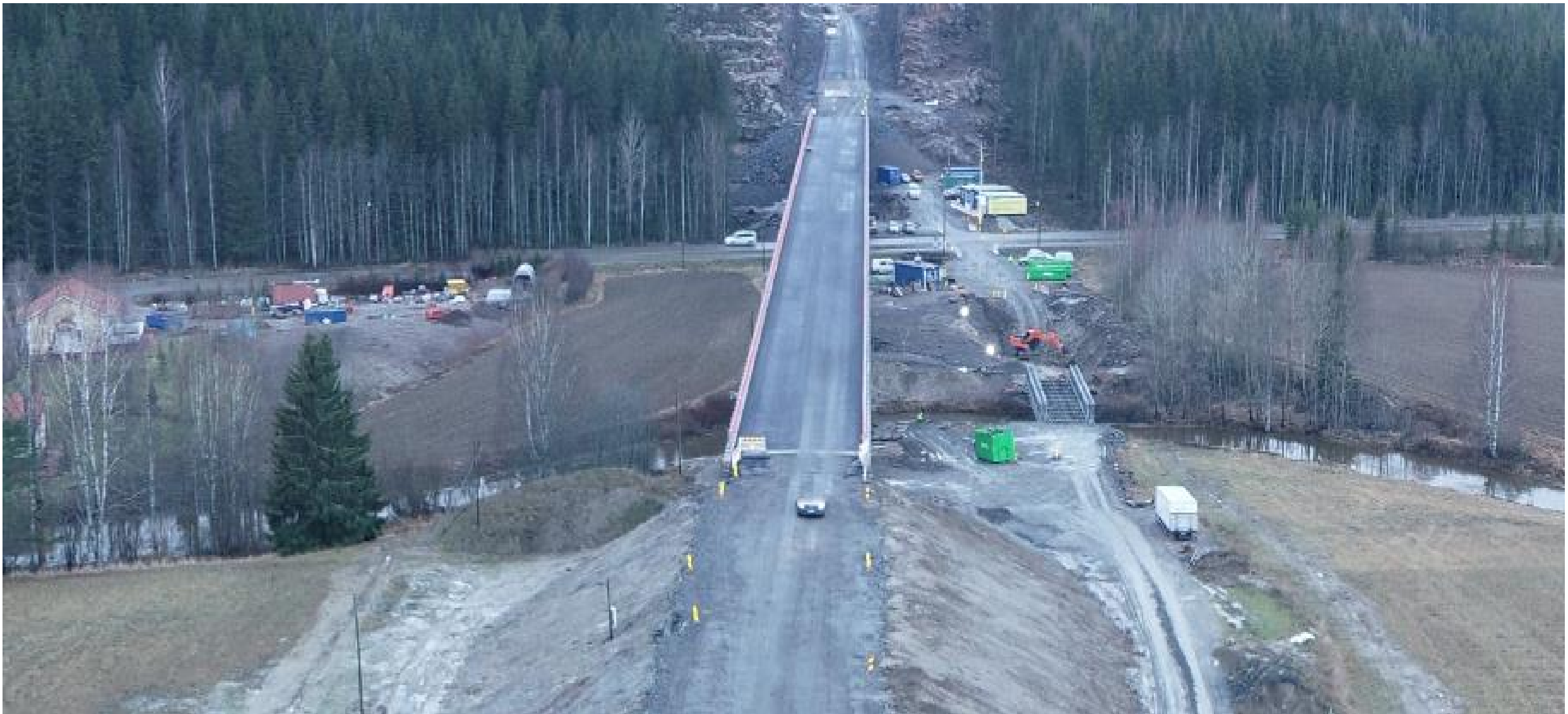
Silta S9 Luhdanjoen silta, näkymä Hollolan suuntaan
