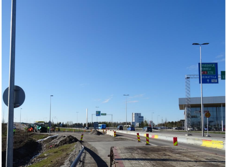
Kuva 5. Uudenmaankadun eteläpäässä olleen kiertotien asfaltointi alkamassa.
