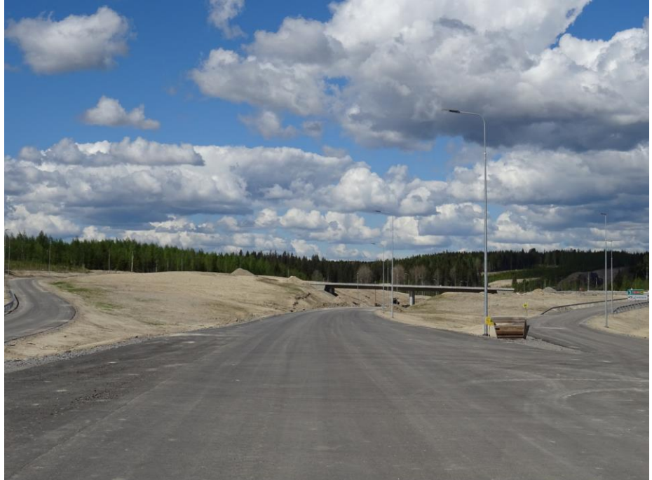
Kuva 1. Nostavan eritasoliittymä idästä
