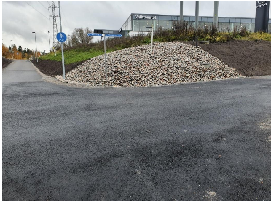
Kuva 3. Aukeankadun jalankulun ja pyöräilyn väylän luiskaverhous
