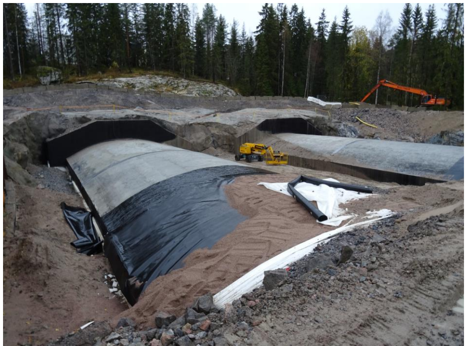
Kuva 1. Välitunnelin vesieristys- ja täyttötöyt
