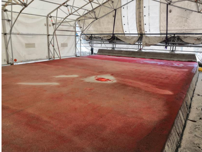
Kuva 5. Aukeankadun alikulkusillan vesieristys
