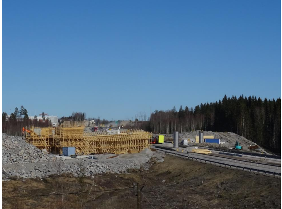
Kuva 4. Kujalan risteyssillan muottia
