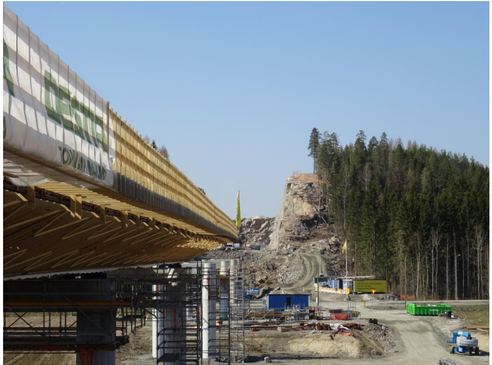
Kuva 1. Luhdanjoen risteysilta, osin paikalleen tunkattuna
