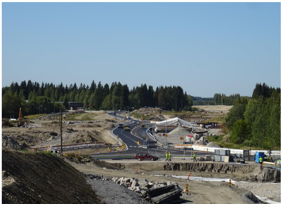
Kuva 4. Helsingintien kiertotie, taustalla Nikulan eritasoliittymän alue
