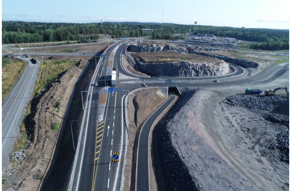
Kuva 1. Soramäen eritasoliittymä etelästä päin (kuva: Destia Oy)
