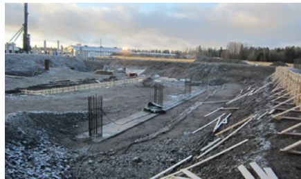
Launeen eritasoliittymän alueen siltatyöt etenivät, kuvassa välituet.
