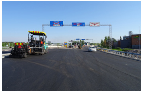
Kesän merkkejä: Asfalttimiehet nähty Uudenmaankadulla!
