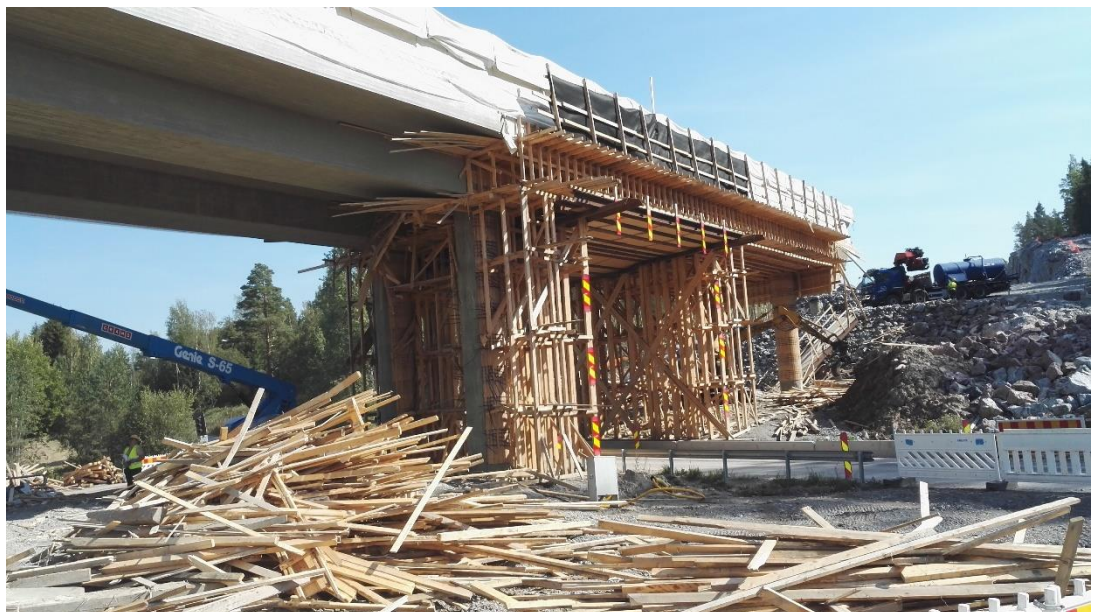
Kuva 2. Sillan S3 telinerakenteiden purkutyöt on käynnissä.
