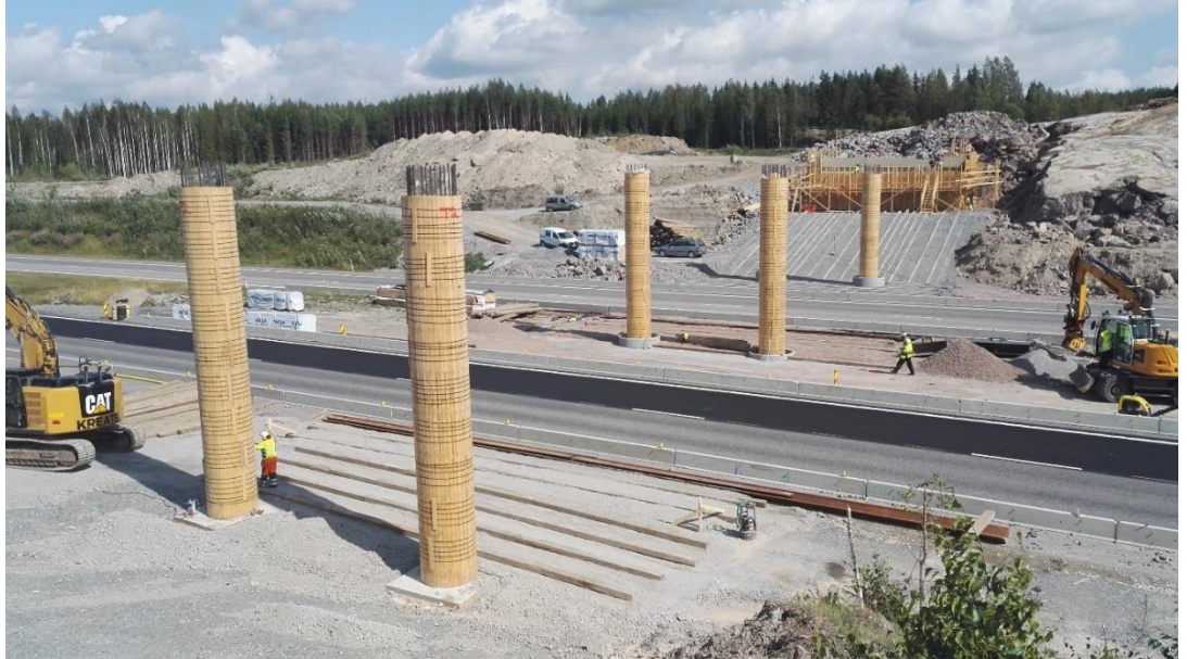
Kuva 1. Valtatien 3 ylittävän sillan S5 pilarit.
