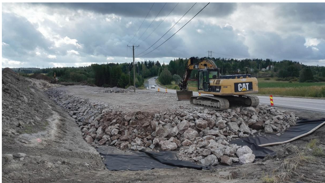
Kuva 4. Suodatinkankaan asennustyöt sekä jakavan kerroksen rakentaminen on käynnissä Numlahden urakka-alueella.
