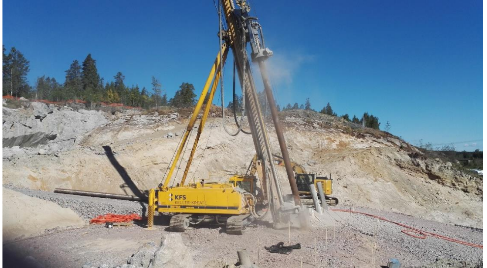
Kuva 2. Kuvanotto hetkellä porapaalutustyöt käynnissä valtatie 3 länsipuolella, 24.6.2019.
