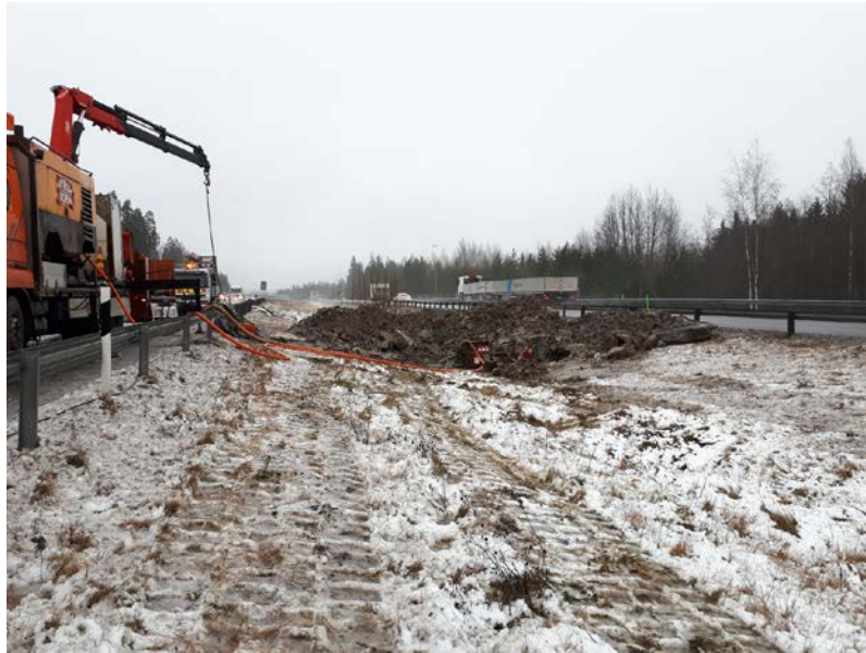
Kuva 6. Alitusporauskaivanto Vt3 keskikaistalla Ilvesvuoren risteyssillan kohdalla, kuva 16.12.2020
