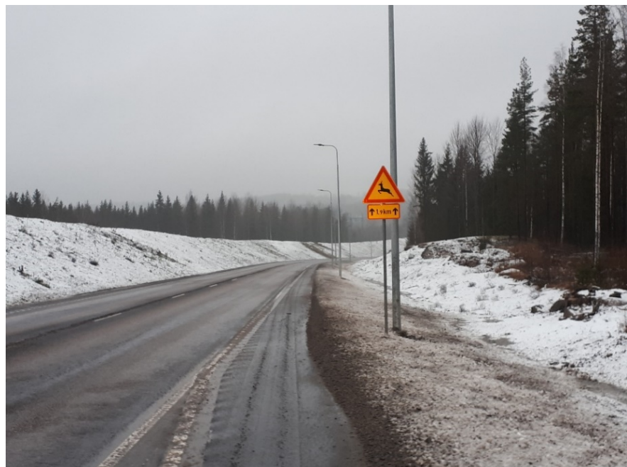
Kuva 3. Peuravaaramerkit asennettu, kuva 16.12.2020
