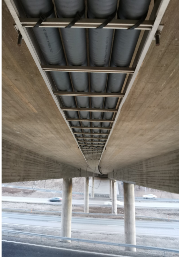
Kuva 1. S5 kaapelihyllyn putkitukset aloitettu, kuva 8.12.2020
