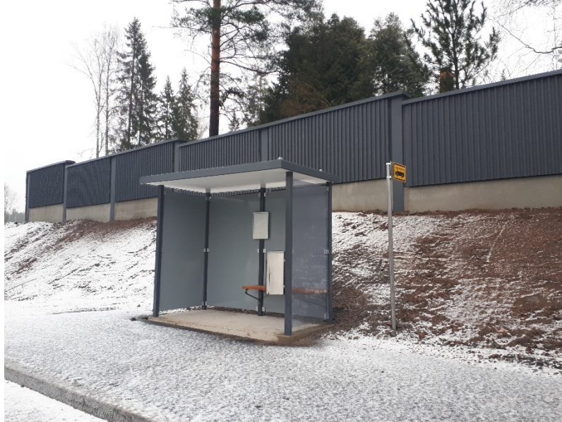
Kuva 4. Kirkkotien pysäkkikatos on asennettu, kuva 16.12.2020
