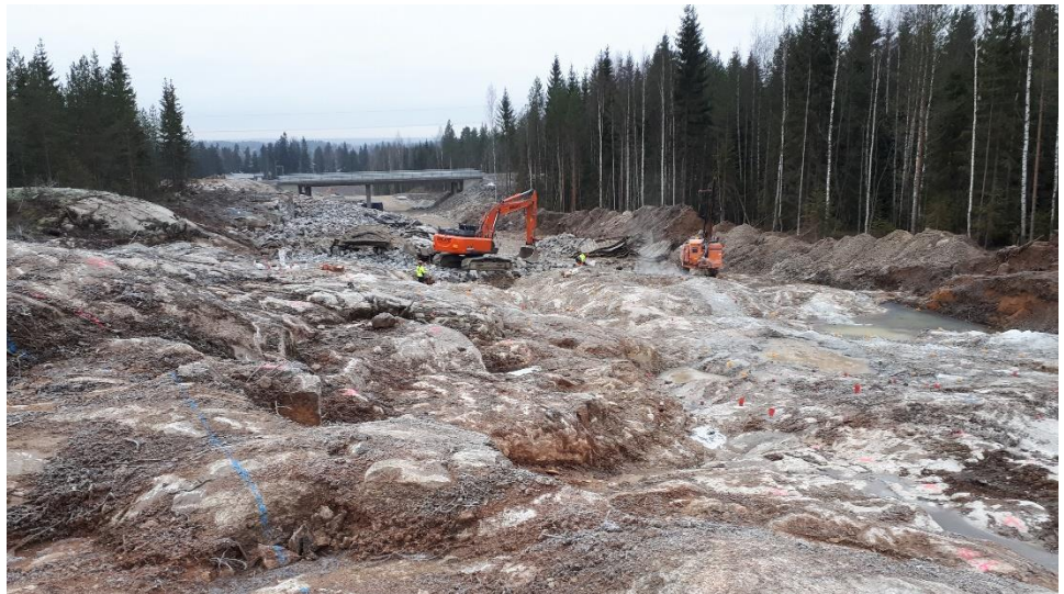
Kuva 4. Kallionporaus on käynnissä tulevalla Kirkkotiellä, Kirkkotien ylittävän sillan pohjoispuolella.
