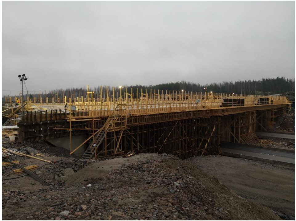
Kuva 1. Vt 3 ylittävä silta kuvattuna itään päin.
