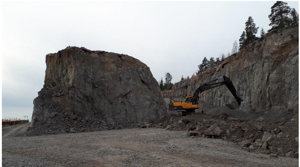
Kuva 3. Vt 3 tulevien ramppien louhinta on käynnissä.
