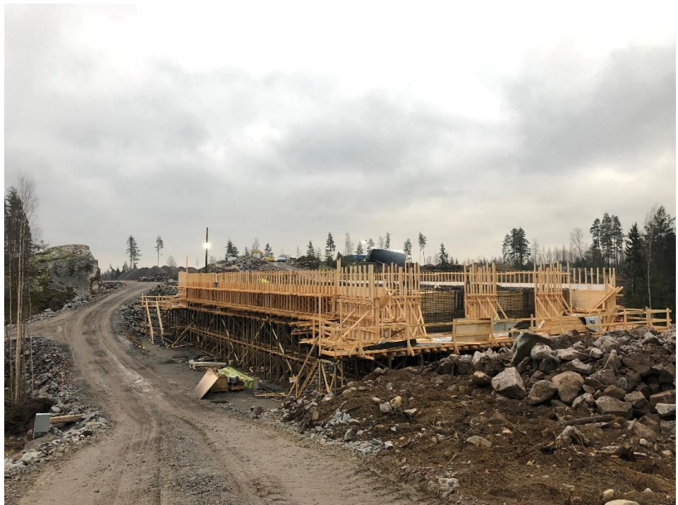
Kuva 2. Työt on käynnissä Luhtajoen risteysillalla.
