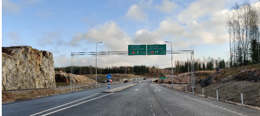
Kuva 5. Liikenneopasteiden asennus käynnissä koko tielinjalla, kuva 28.10.2020
