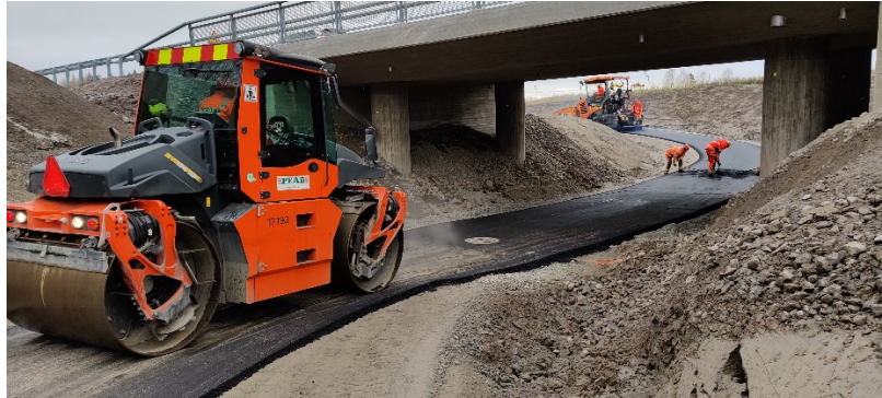
Kuva 1. S104 alittavan kevyen liikenteen väylän päällystystyöt käynnissä, kuva 20.10.2020
