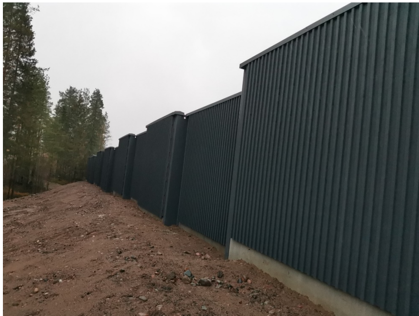
Kuva 3. Me 4+5 meluseinät valmiit, kuva 22.10.2020
