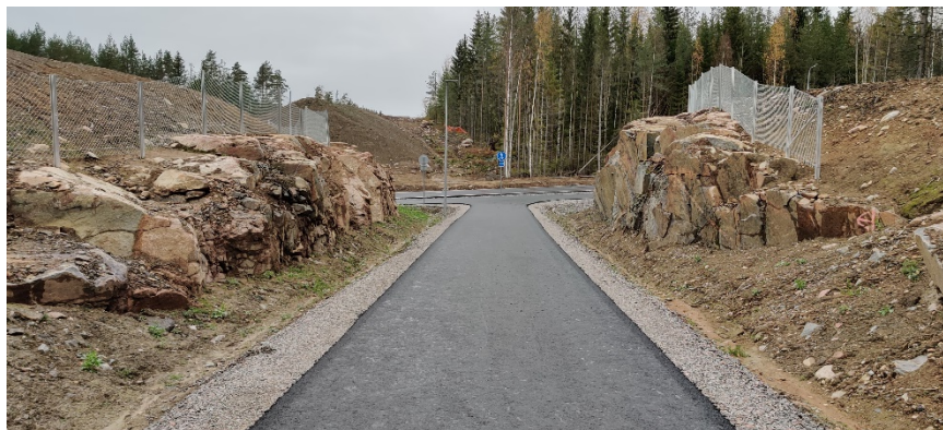
Kuva 4. Kirkkotien läheisyydessä oleva kevyen liikenteen väylä päällystetty, riista-aidat ja liikennemerkit asennettu, kuva 22.10.2020
