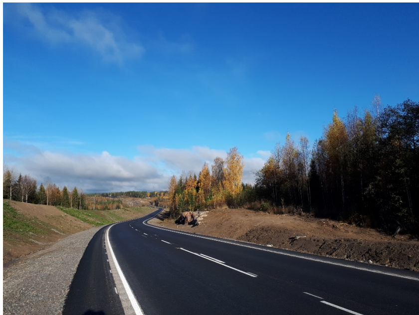
Kuva 2. Ohikulkutien päällystys, ajoratamerkinnot ja heräteraidat pääosin tehty, kuva 15.10.2020
